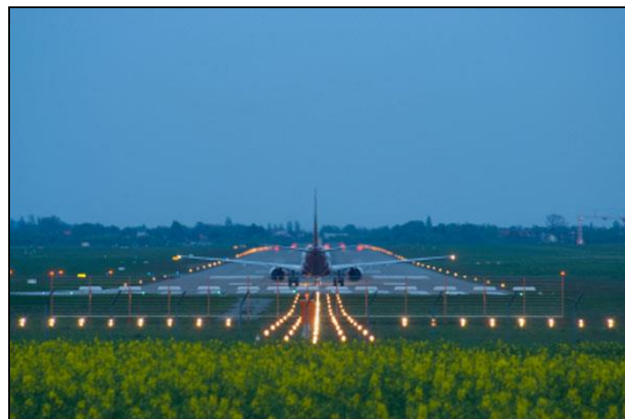
Figura 16 - Iluminação de pistas de aeroportos.
