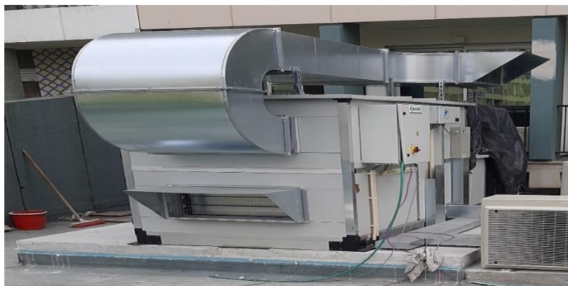
Figura 2.4 - UTA da obra do Sindicato dos Bancários do Centro.
