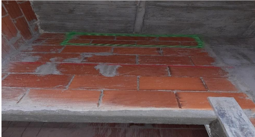
Figura 3.1 - Marcação de Roços na obra do Centro de Saúde da Av. Fernão Magalhães, Coimbra.
