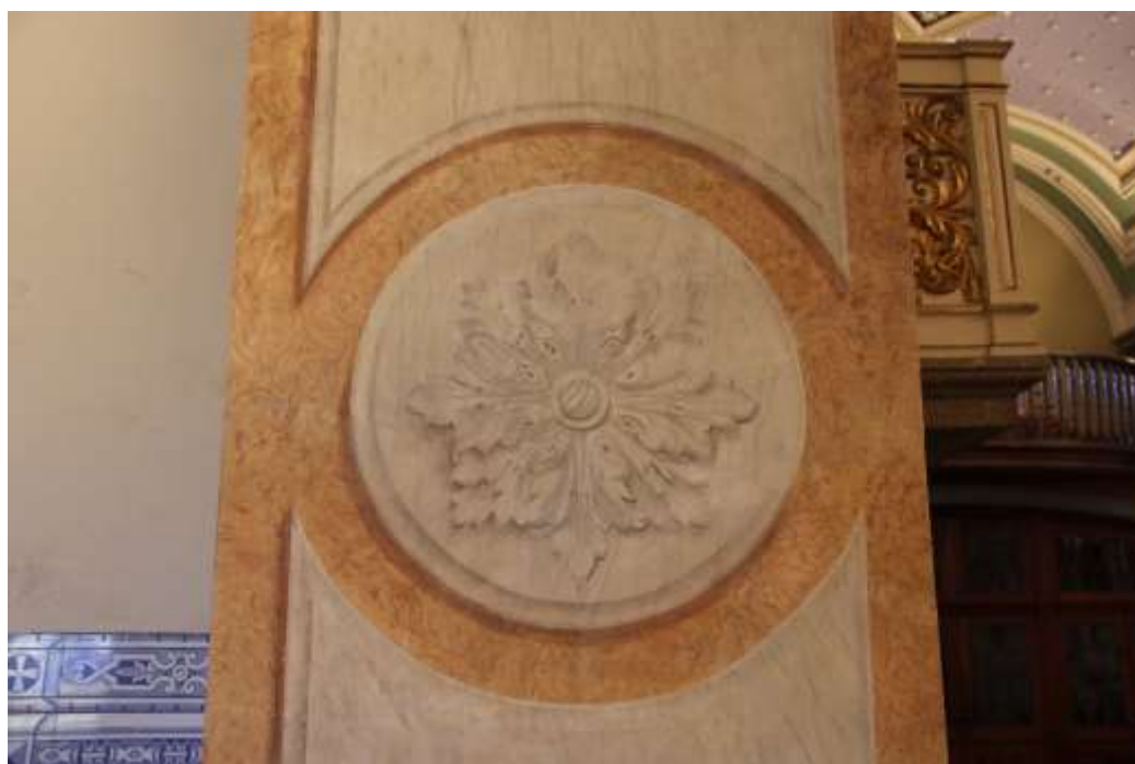
Figura 49 - Estado Final da Intervenção no Arco da Capela Lateral do Lado da Epístola. - C.F. - Autoria Própria.
