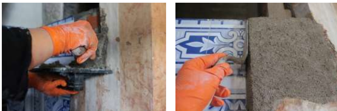
Figura 31 - Aplicação de Argamassa com Base em Areia de Rio Escura e Cal Hidráulica. C.F – Autoria Própria.
