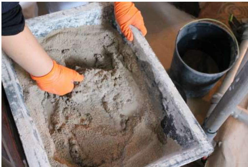
Figura 48 - Execução da Argamassa com Base em Areia de Rio Escuro e Cal Hidráulica. - C.F. – Carla Matos.
