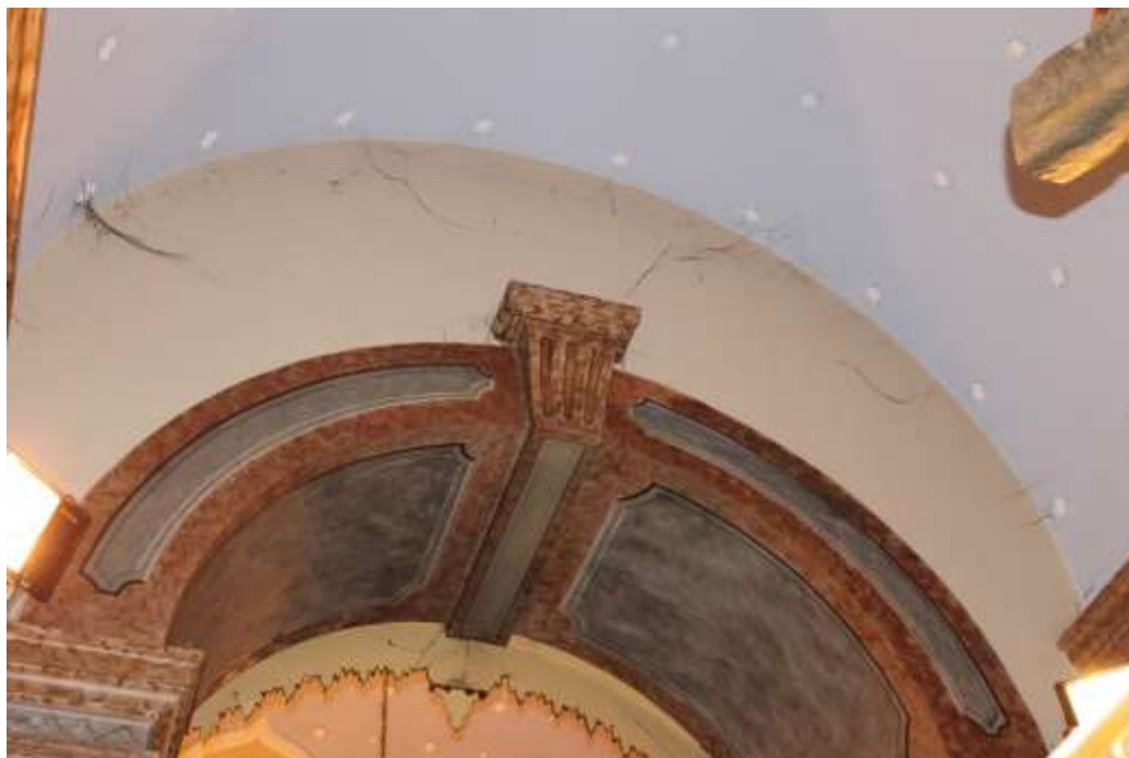
Figura 40 - Detalhe Pedra de Fecho do Arco da Capela Lateral do Lado da Epistola. - C.F. -Autoria Própria.
