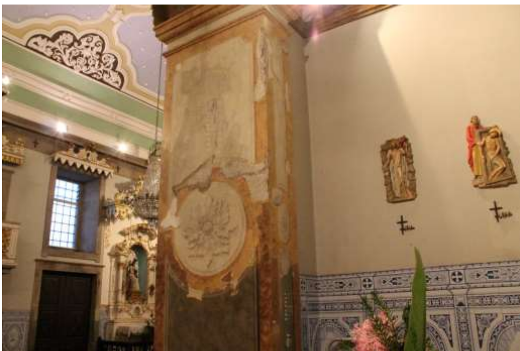
Figura 47 - Detalhe do Avanço da Remoção de Repolichromias no Arco da Capela Lateral do Lado da Epístola. - C.F. - Autoria Própria.
