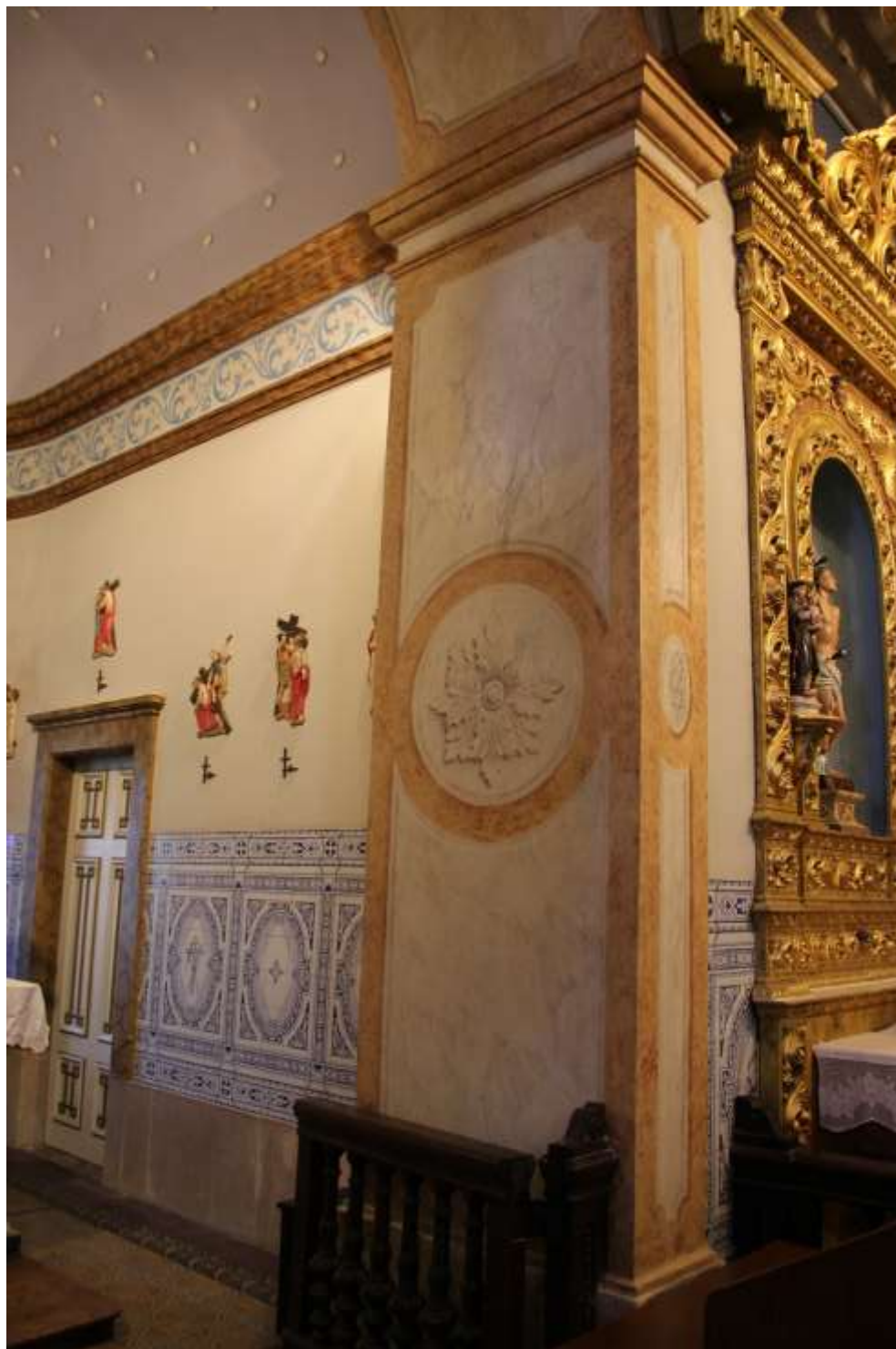
Figura 51 - Estado Final da Intervenção no Arco da Capela Lateral do Lado do Evangelho- C.F. - Autoria Própria.
