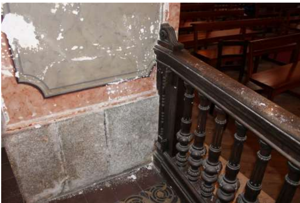
Figura 43 - Portão da Capela Lateral do Lado da Epístola. - C.F. - Autoria Própria.
