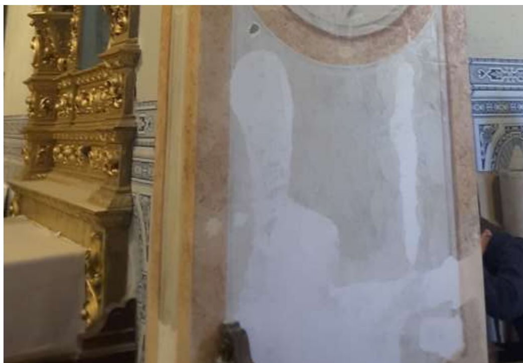
Figura 33 - Aplicação de Argamassas com Base em Gesso. - C.F – Autoria Própria.
