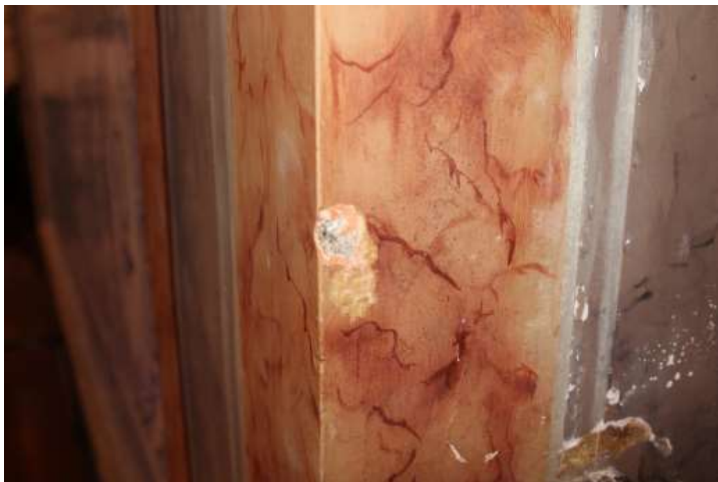
Figura 44 - Lacuna Volumétrica de Pequenas Dimensões no Arco da Capela do Lado da Epístola. - C.F. - Autoria Própria.
