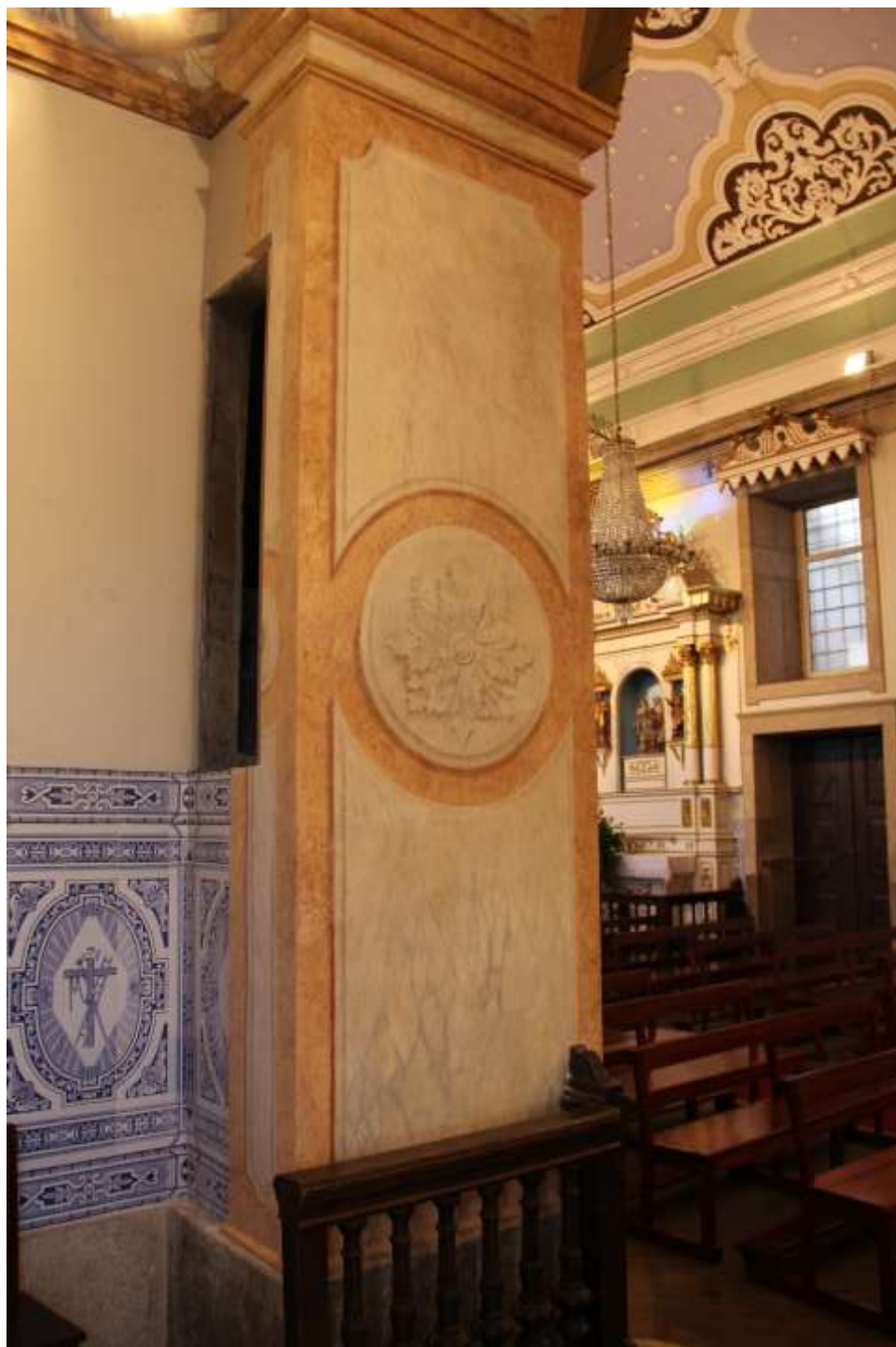
Figura 50 - Estado Final da Intervenção no Arco da Capela Lateral do Lado da Epístola. - C.F. - Autoria Própria.
