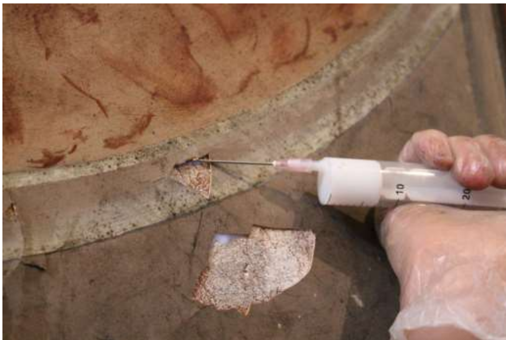
Figura 20 - Injeção de Primal®B60-A Diluído em Água Destilada. - C.F – Autoria Própria.
