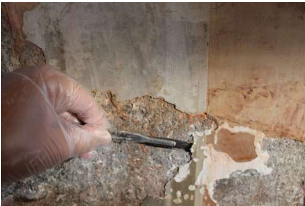
Figura 27 - Remoção das Argamassas com Base em Gesso. C.F – Autoria Própria.
