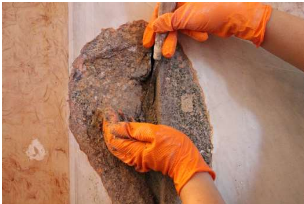
Figura 32 - Aplicação de Argamassa com Base em Areia de Rio Escura e Cal Hidráulica. C.F – Autoria Própria.
