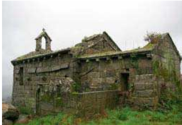
Foto 1 – Igreja S. Mamede Vila Verde, em Felgueiras. Antes da Intervenção
