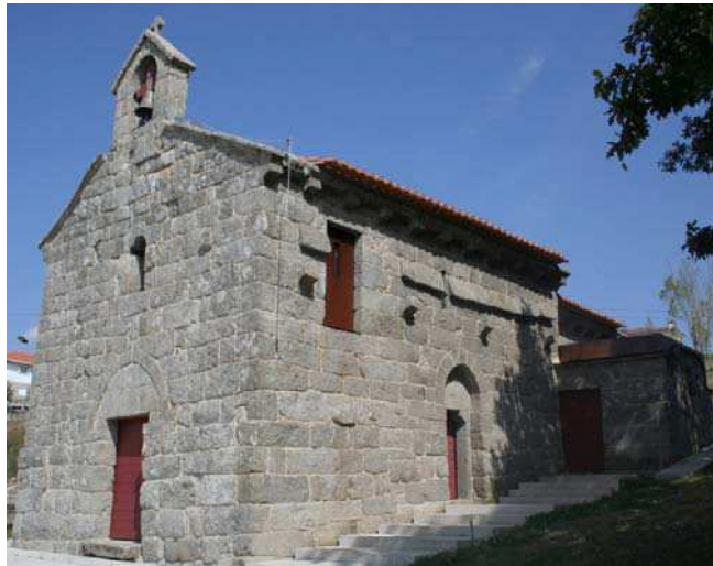
Foto 2 – Igreja de S. Mamede Vila Verde, em Felgueiras. Depois da Intervenção
