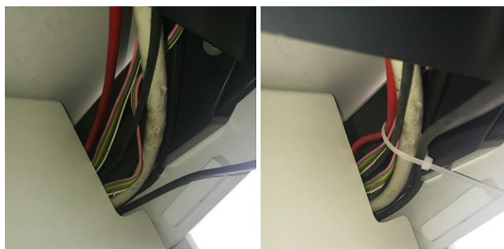
Figura 69: Estado dos cabos antes e depois da intervenção.
