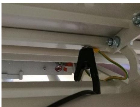
Figura 54: Teste de Segurança Elétrica a uma cama elétrica: colocação num ponto metálico.
