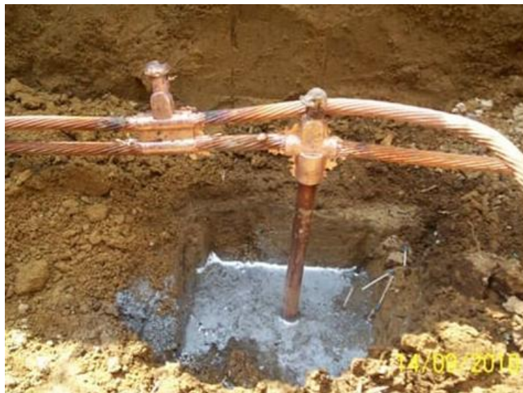
Figura 12 - Terra de Proteção [17]
