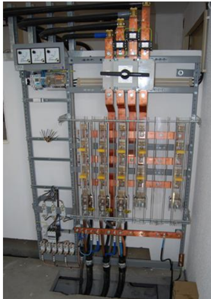
Figura 9 - Exemplo de Quadro Geral BT [13]
