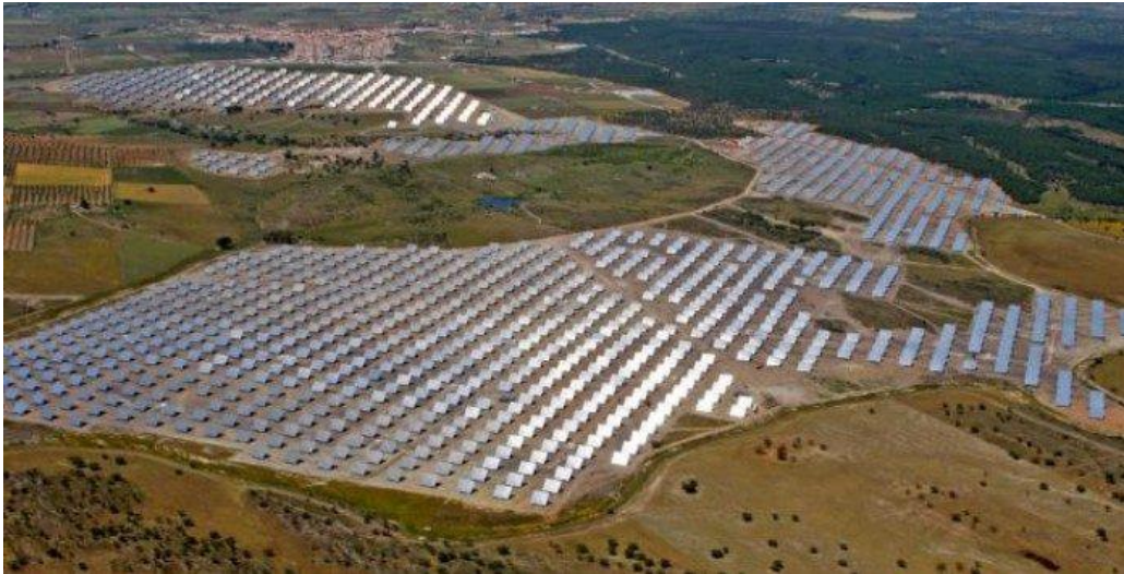
Figura 2.18 - Central solar fotovoltaica de Amareleja (Portal Energia, 2008)
