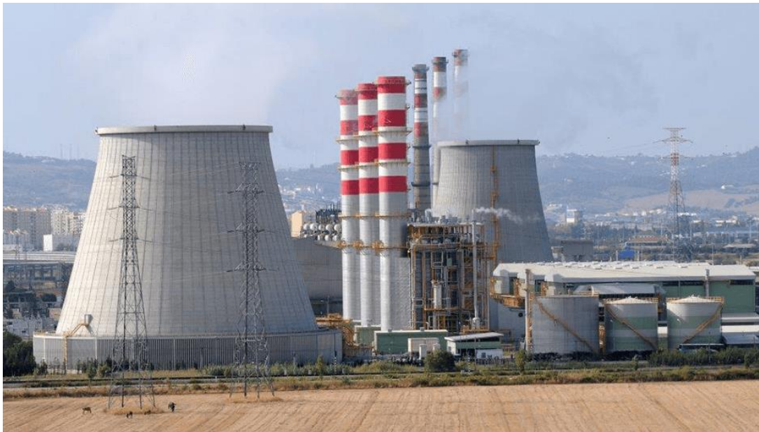
Figura 2.10 - Central termoelétrica Ribatejo (EDP, 2021c)
