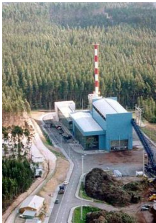
Figura 2.22 - Central biomassa Mortágua (Energias Renováveis, 2021)
