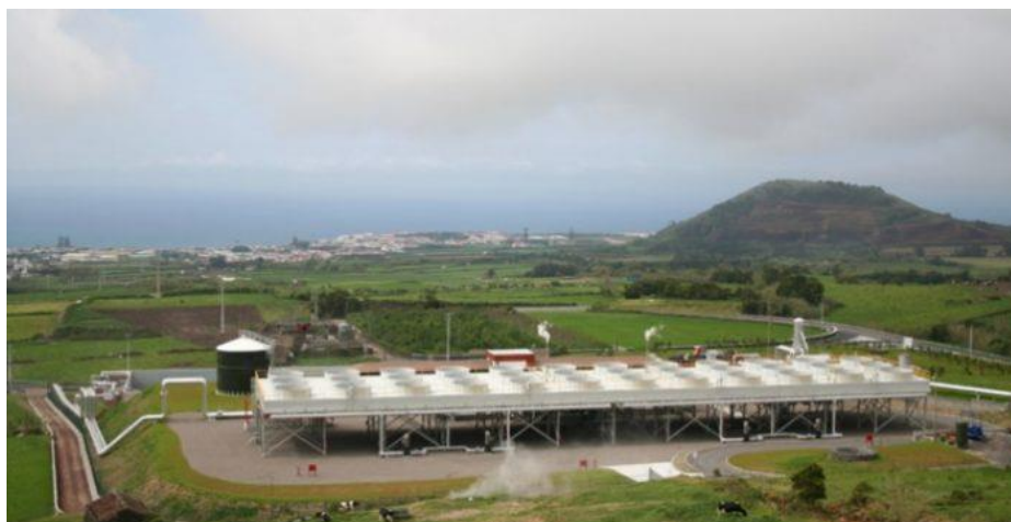
Figura 2.24 - Central geotérmica do Pico Vermelho Açores (Portal Energia, 2009)
