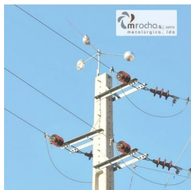
Figura 34 - Dispositivo Anti Nidificação [26]
