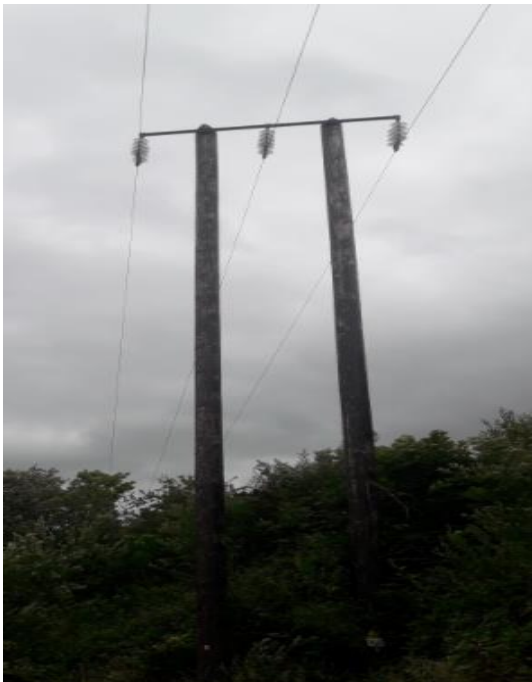
Figura 14 - Portal de madeira numa linha de 38kV utilizado na Irlanda [15]
