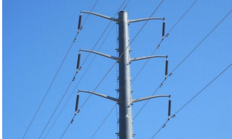
Figura 17 - Apoio em material compósito [20]
