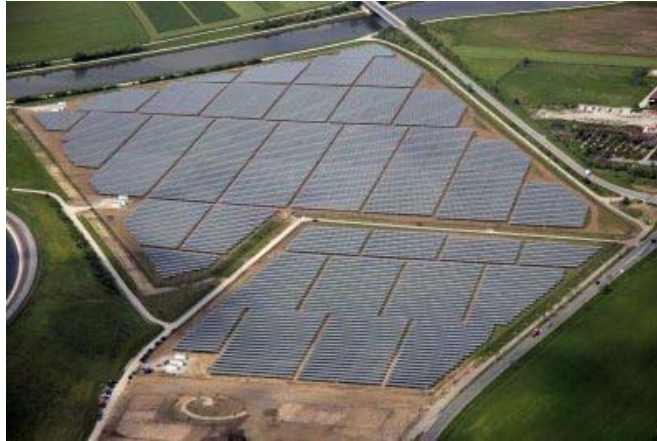
Figura 2 – Central solar fotovoltaica da Amareleja
