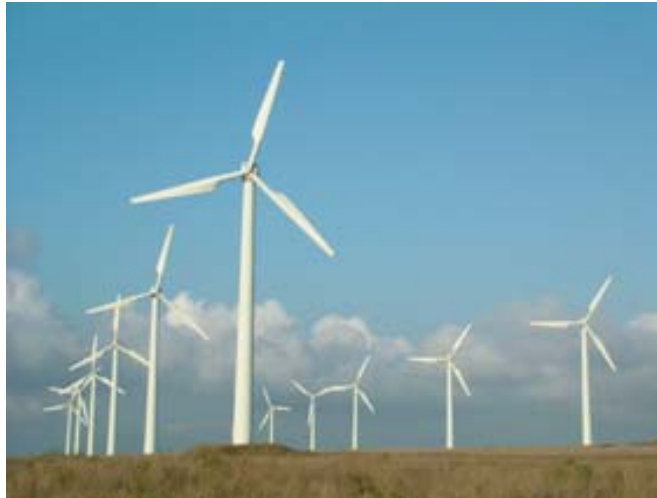
Figura 1 – Parque eólico do Alto Minho em Monção
