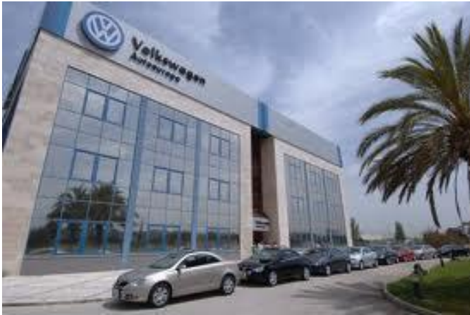
Figura 3 - Edifício Principal da VW AE.
