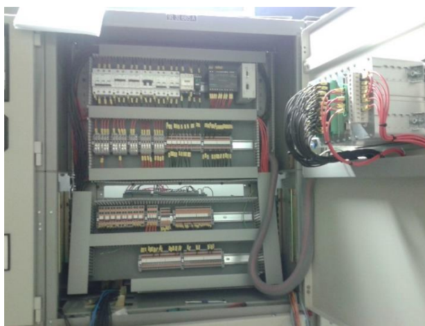
Figura 4.21 – Montagem da cela 91.31 665A
