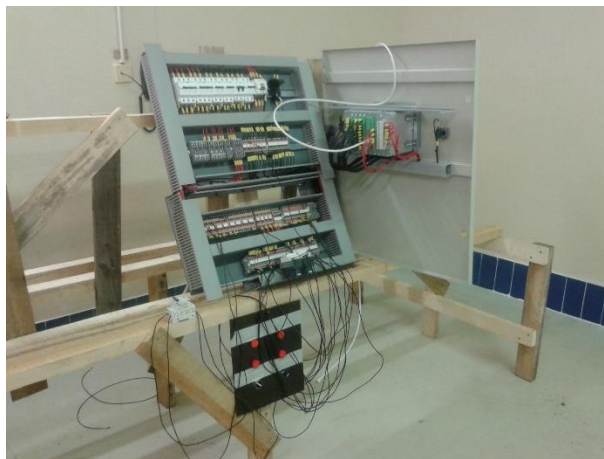
Figura 4.16 – Bancada de ensaios com a platina com disjuntores e equipamentos de ligação da cela de entrada 91.39 02
