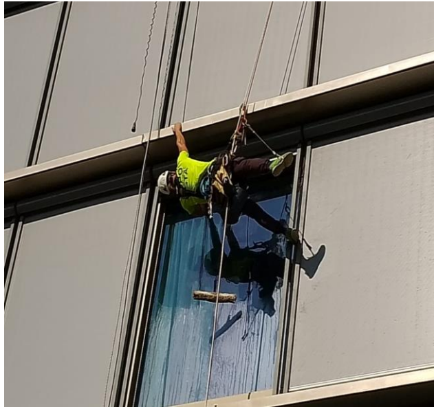
Figura 21 - Postura forçada e base instável do trabalhador ao lavar o vidro no canto superior esquerdo da janela com o rodo.
