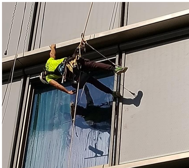
Figura 20 - Postura forçada e base instável do trabalhador a trocar de ferramenta da esponja para o rodo para remover a água do canto superior esquerdo do vidro.
