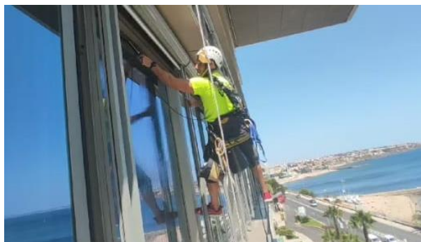
Figura 15 - Flexão do braço acima do 90° por parte do trabalhador ao lavar o canto superior esquerdo do vidro
