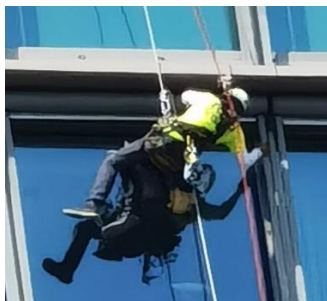
Figura 10 - Flexão lateral do tronco realizada pelo trabalhar na limpeza do canto superior direito do vidro
