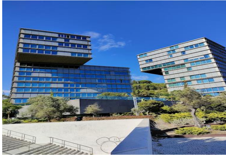
Figura 4 - Estoril Sol Residence, vista poente
