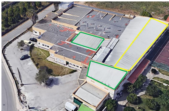
Figura 23 - Edifício para futura instalação da UPAC
