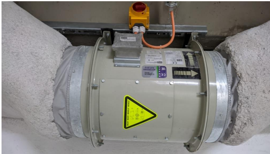
Figura 2.7 – Ventilador extrator em linha para condutas.
