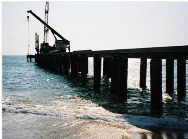
Figura 28 - Construção da Ponte Cais
