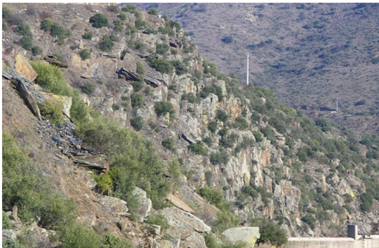
Figura 9. Encosta instável onde se verifica a queda de vários blocos, felizmente em áreas onde não existem afloramentos gravados.
