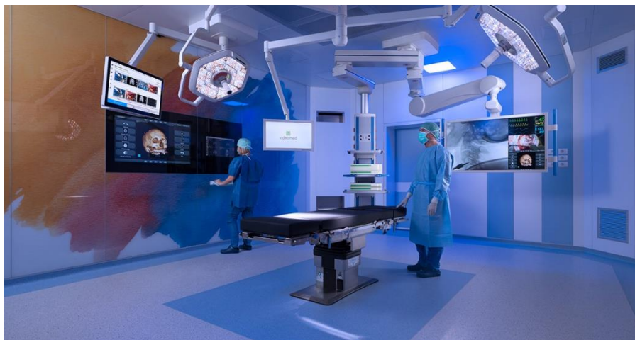
Figura 3.7 – Configuração de um BO: Mesa operatória, pendentes e candeeiros operatórios marca Trumph, sistema de vídeo-integração marca Videomed
