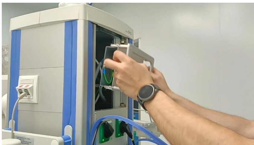
Figura 3.9 – Remoção de módulo de tomadas elétricas de um pendente Truport
