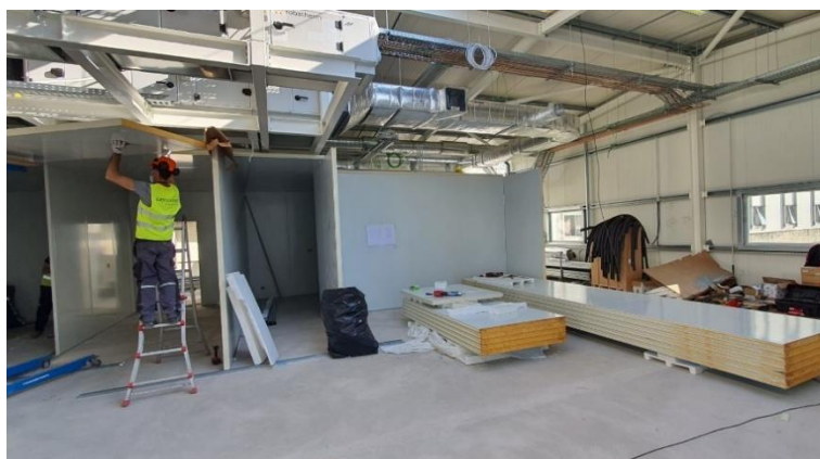
Figura 3.38 – Instalação das estruturas modulares em outubro de 2020
