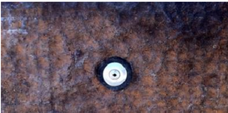
Figura 18 – Reparação provisória exterior de uma tubagem no TGLS.
