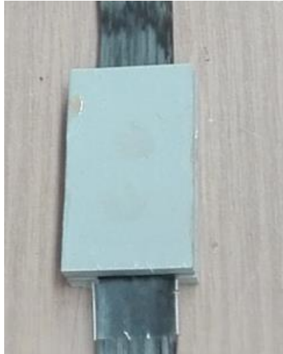
Figura 22 – Proteção das fibras de carbono, com resina epóxi e chapas compósitas.
