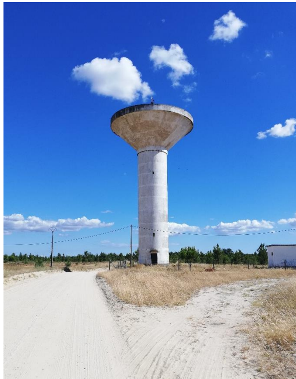
Figura 7 - Depósito de água de Poceirão.
