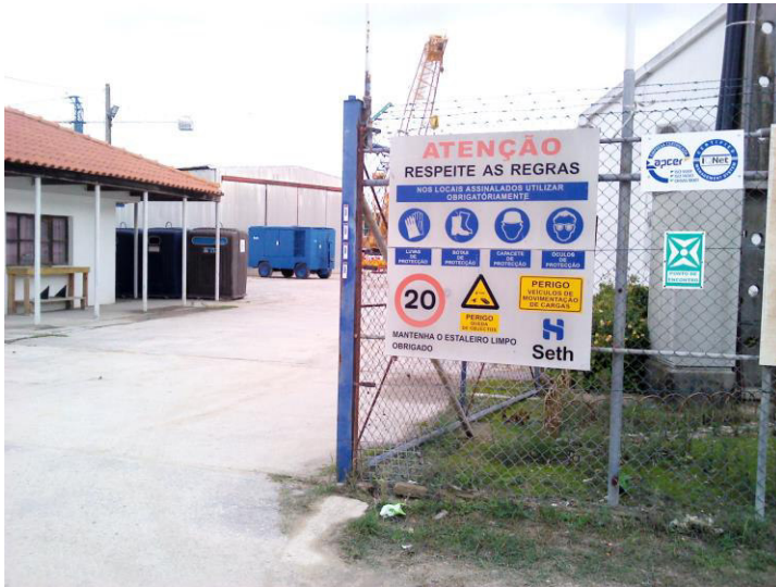
Figura 1 – Entrada do Estaleiro
