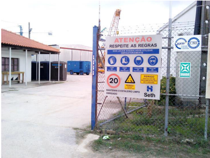
Figura 1 – Entrada do Estaleiro
