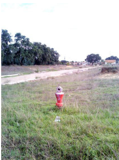
Figura 4 B- Hidrante
