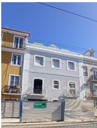
Figura 23 - Empreitada Edifício Habitacional Junqueira fase de acabamentos
