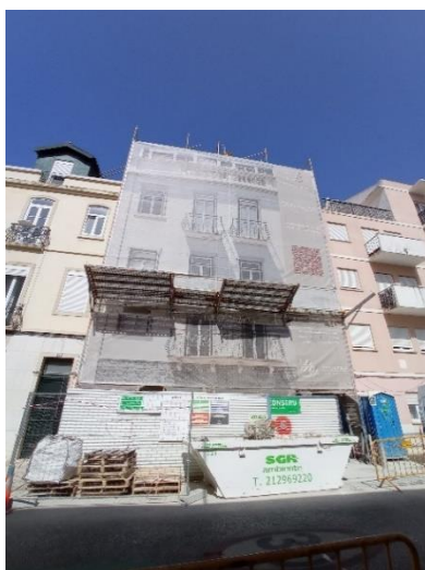
Figura 13 - Empreitada Edifício Habitacional Campo de Ourique fase de execução
