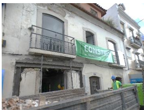
Figura 20 - Empreitada Edifício Habitacional Junqueira fase inicial
