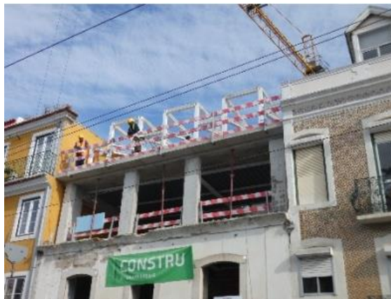
Figura 21 - Empreitada Edifício Habitacional Junqueira fase de execução
