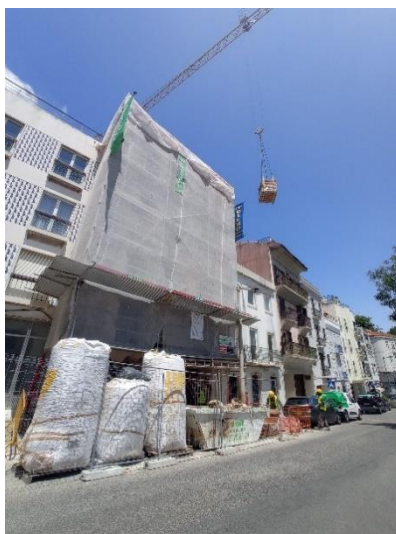
Figura 9 - Empreitada Edifício Habitacional Sto. António à Estrela fase de execução
