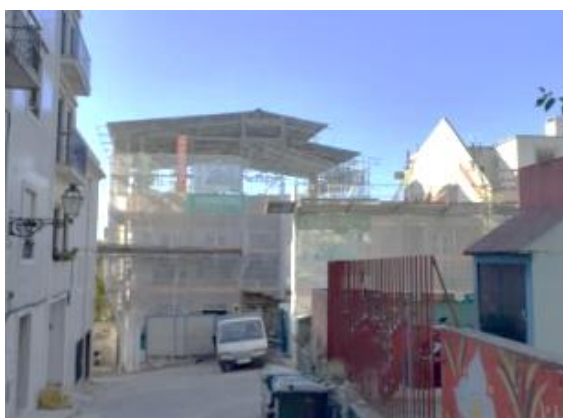
Figura 25 - Empreitada Unidade Hoteleira, Graça fase de execução (fachada)
