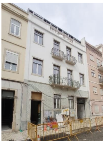
Figura 15 - Empreitada Edifício Habitacional Campo de Ourique fase de acabamentos Fonte – Autor
