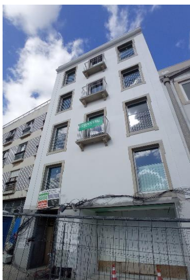
Figura 11 - Empreitada Edifício Habitacional Sto. António à Estrela fase de acabamentos
