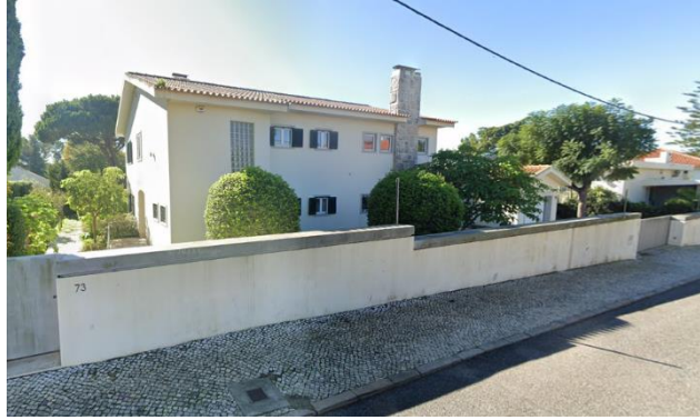
Figura 28 - Empreitada habitação unifamiliar Carcavelos fase inicial (edifício pré-existente)
