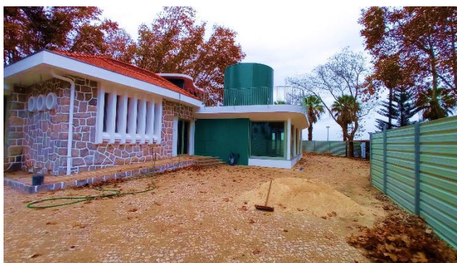
Figura 19 - Empreitada Estabelecimento Comercial Paço de Arcos fase de acabamentos
