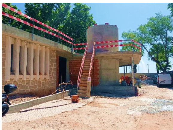
Figura 17 - Empreitada Estabelecimento Comercial Paço de Arcos fase de execução
