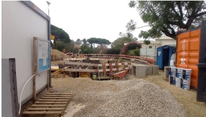
Figura 29 - Empreitada habitação unifamiliar Carcavelos fase de execução
