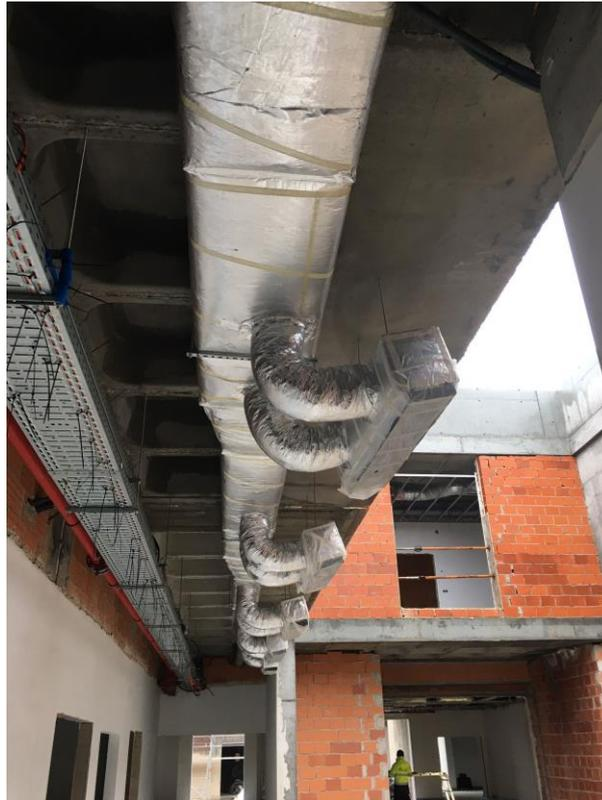
Figura 4.9 - Plenos instalados e tapados
