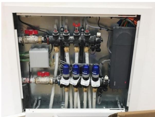
Figura 3.13 - Caixa circuito piso radiante
