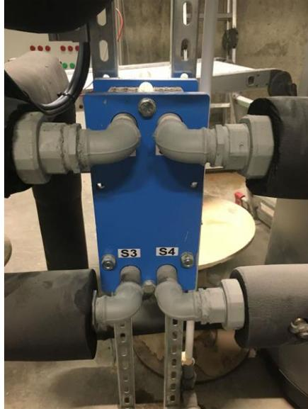
Figura 4.7 - Permutador de calor de placas
