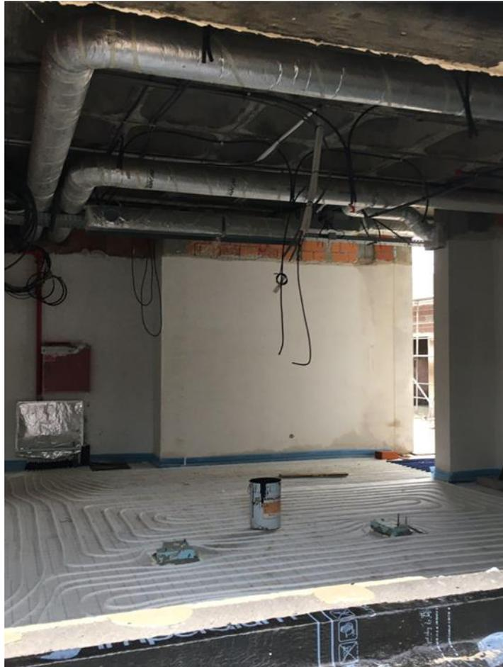
Figura 4.10 - Circuito de piso radiante descoberto
