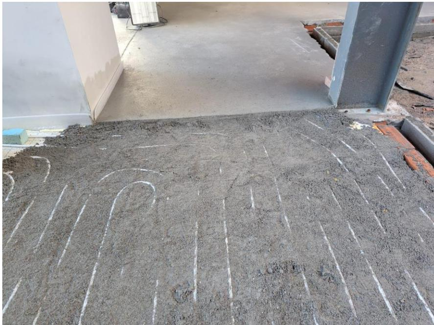
Figura 4.11 - Circuito de piso radiante parcial e totalmente coberto
