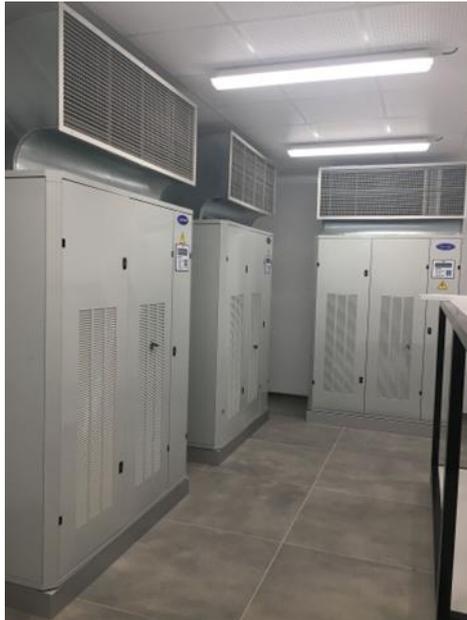
Figura 4.2 - Equipamento de *Close Control*
