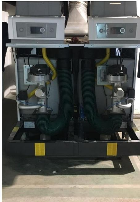
Figura 3.9 – Caldeiras de condensação instaladas
