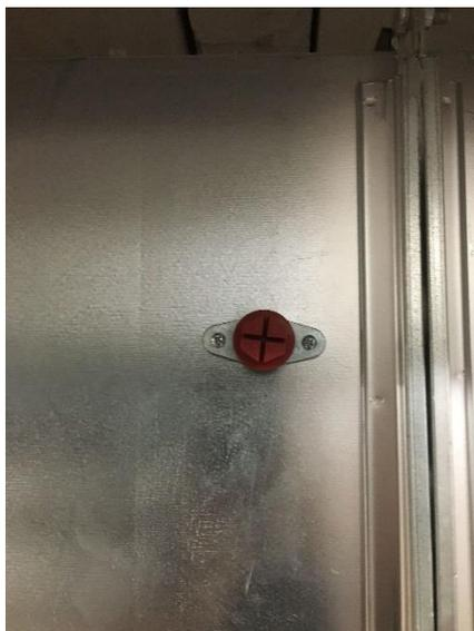
Figura 3.21 - Furo de prova tamponado
