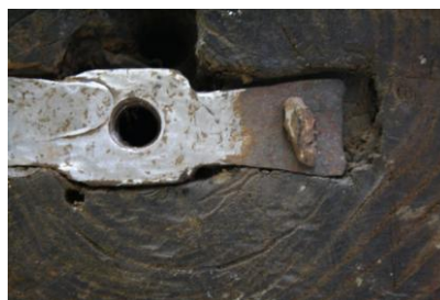
Figura 85 – Durante o processo de desoxidação
