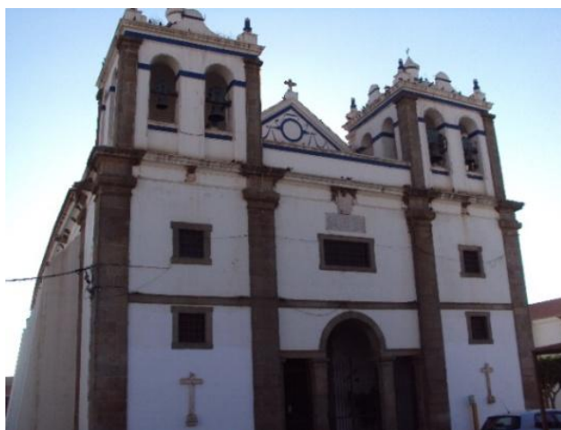
Figura 5 - Fachada principal da Igreja Matriz da Nossa Senhora da Atalaia.
