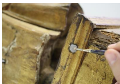
Figura 87 – Aplicação da cera de abelha com essência de terebintina
