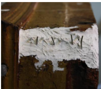
Figura 91 – Reconstituição volumétrica do canto da base.
