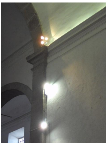
Figura 8 - Focos de iluminação, na capela-mor
