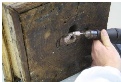
Figura 84 – Desoxidação do elemento metálico com mó abrasiva.
