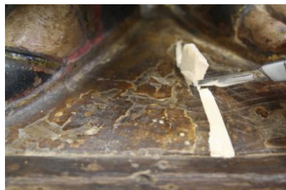
Figura 88 – Preenchimento de fenda com balsa.
