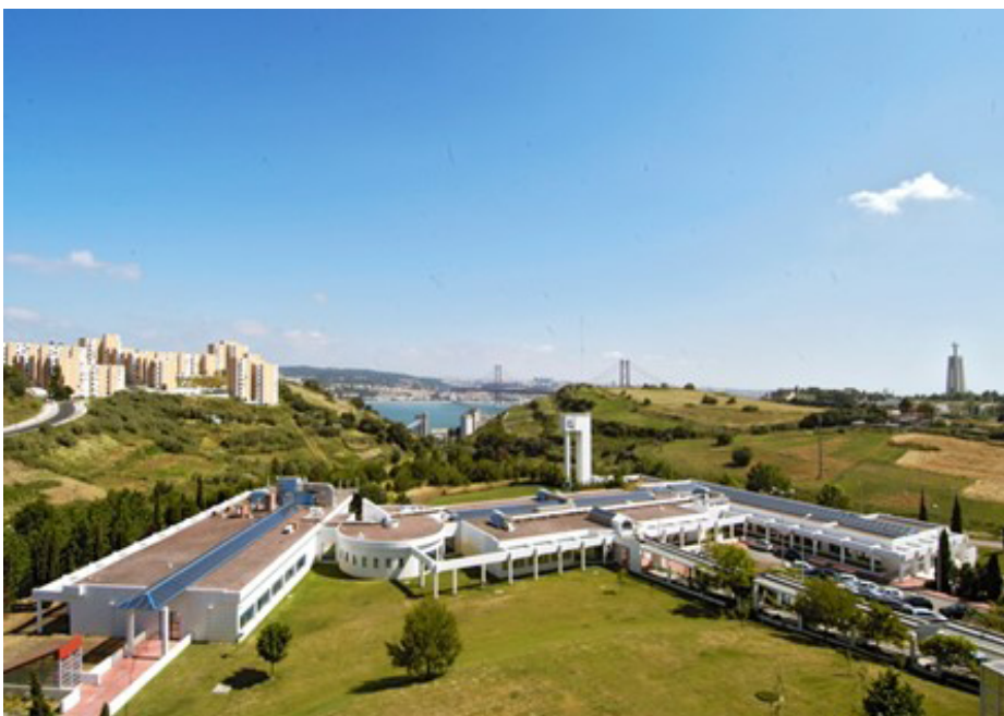
Figura 2: Vista do Laboratório Nacional de Metrologia do Instituto Português da Qualidade
