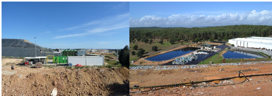
Figura 5- Central de biogás e respetivas lagoas de tratamento de lixiviado. [Fonte: Cedida pela Resitejo]
