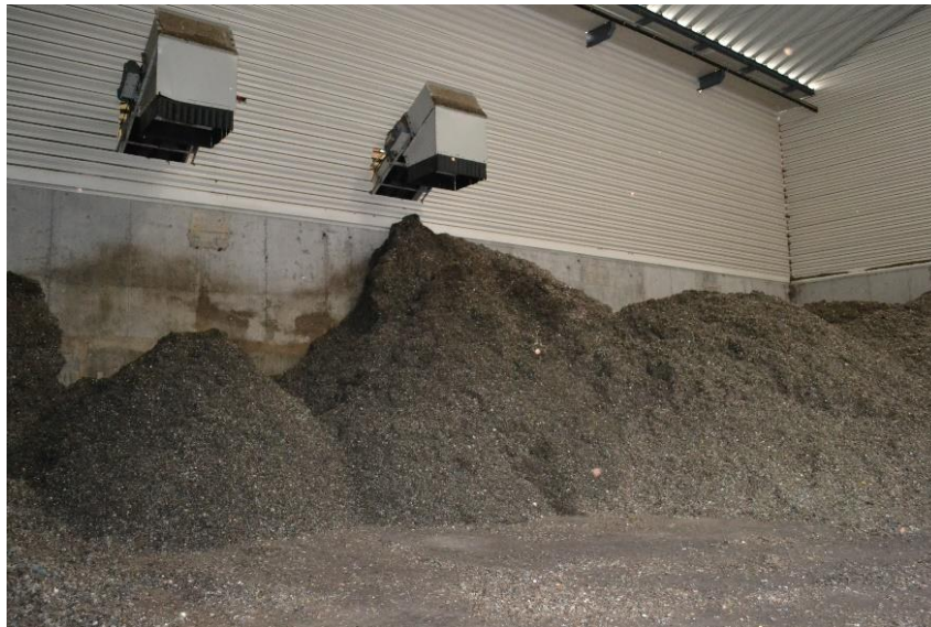
Figura 33- Zona de deposição do CDR proveniente dos Trituradores Secundários. [Fonte: Cedida pela Resitejo]
