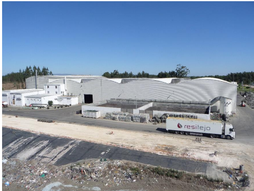
Figura 16- Vista aérea da Unidade de Tratamento Mecânico e Biológico. [Fonte: Cedida pela Resitejo]
