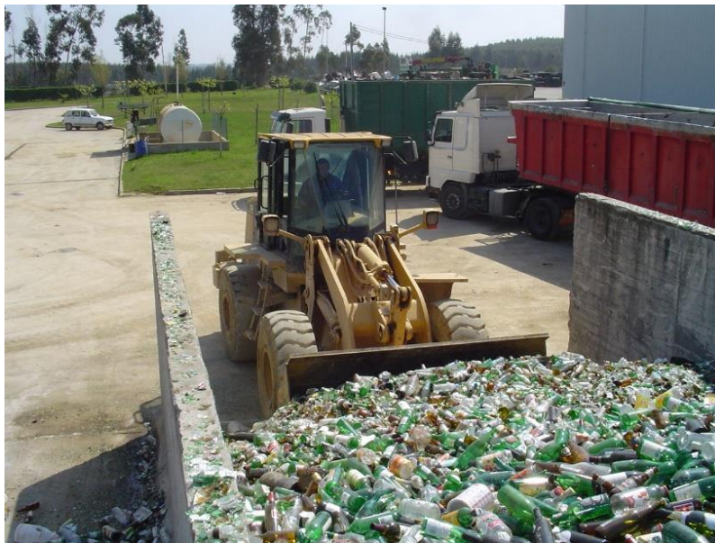
Figura 8- Armazenamento de vidro na Estação de Triagem. [Fonte: Cedida pela Resitejo]
