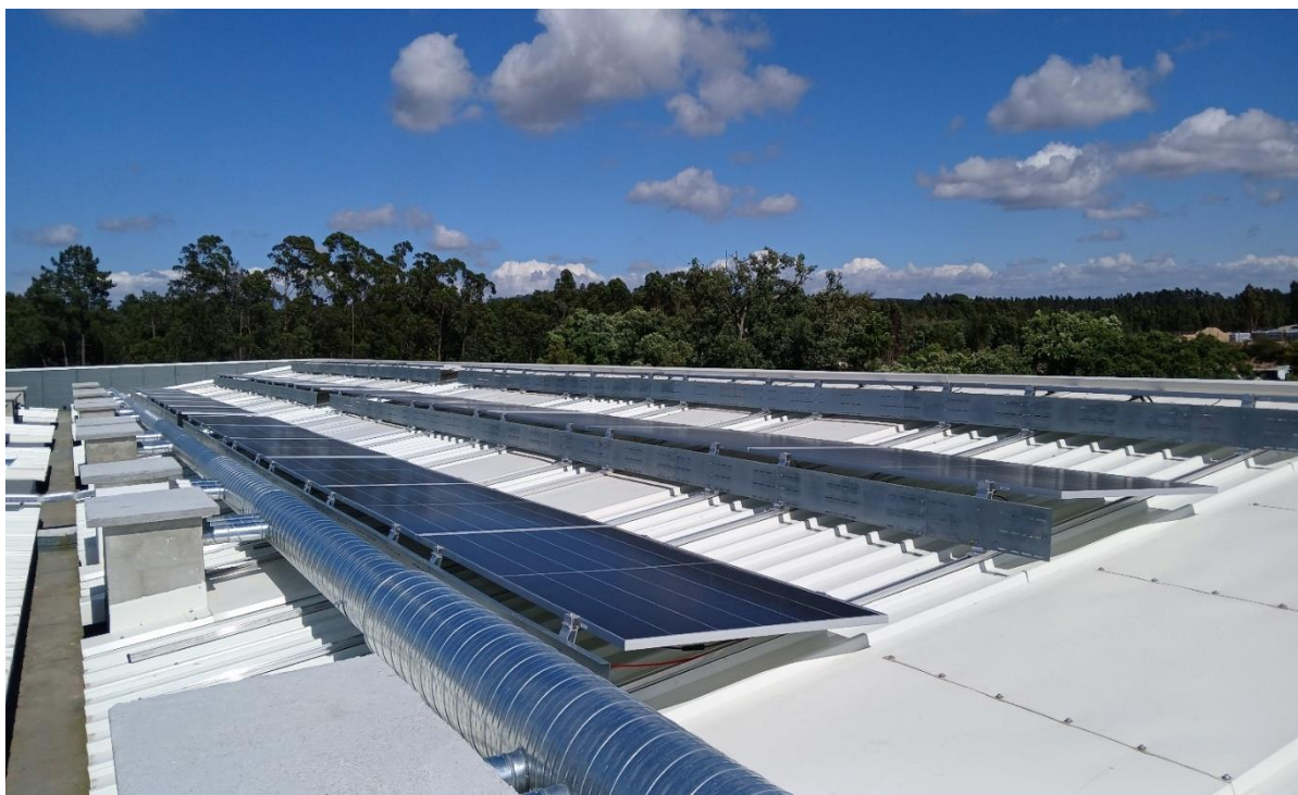
Figura 2.19 – Instalação de Painéis Fotovoltaicos
