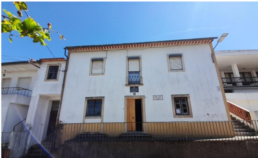
Figura 1. Fachada exterior do Museu Rural e Etnográfico de Alviobeira, Habitação Rural do Século XIX
