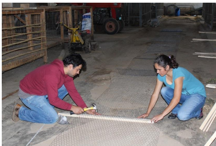
Figura 16 - Construção das cercas
