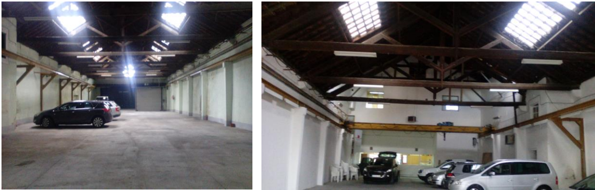
Figura 19 e 20 – Interior do edifício em estudo (fotografia da autora)
