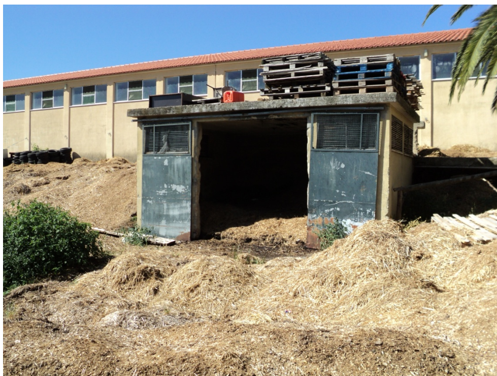
Ilustração 147 – Imagem da estrumeira coberta. Referência 5.
