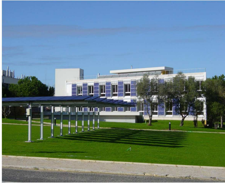
Figura 4.3 – Painéis fotovoltaicos instalados no estacionamento e fachada sul do edifício Solar XXI
