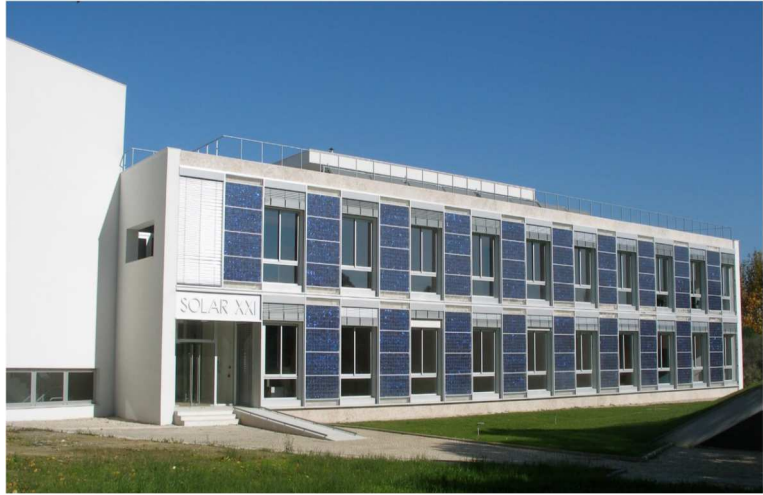
Figura 4.1 – Foto da Fachada sul do edifício Solar XXI em Lisboa
