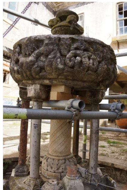
Figura 24: estrutura metálica de suporte ao empuxo do bojo da fonte.
