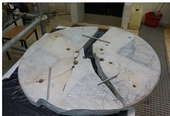
Figura 41: posicionamento dos espigões na base das representações de leões da fonte decorativa.
