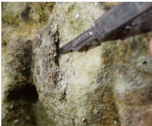
Figura 50: material pétreo em destacamento no bojo.
