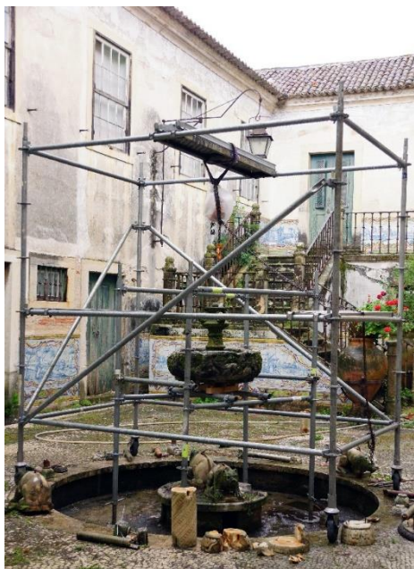
Figura 23: estrutura metálica utilizada para a desmontagem da fonte decorativa.
