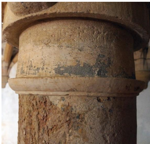
Figura 8: preenchimento com cimento Portland numa das colunas da adega dos Frades.
