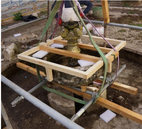
Figura 25: posicionamento das lingas de carga e da estrutura de madeira, para evitar tensões no bojo durante a desmontagem.
