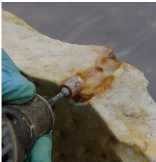
Figura 38: processo de desbaste do mármore.
