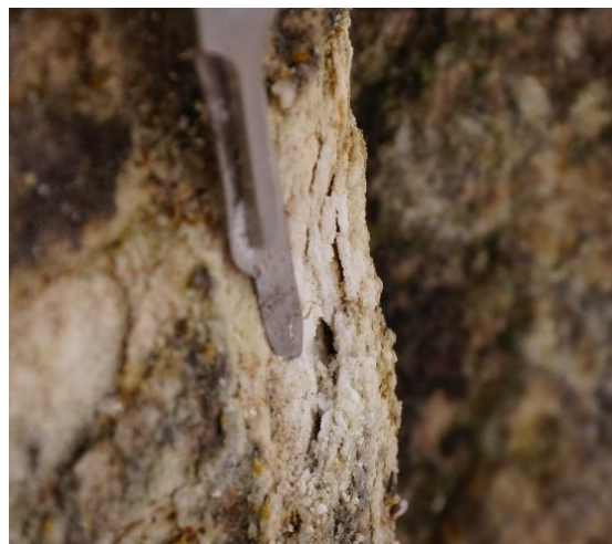
Figura 51: material pétreo em destacamento no bojo.
