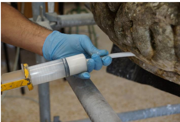
Figura 57: injeção de resina epóxida nas perfurações efetuadas.
