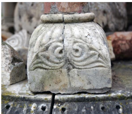
Figura 13: colagem efetuada numa intervenção anterior.
