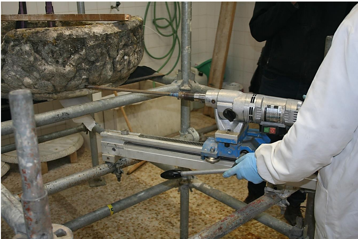
Figura 56: execução de perfurações para a introdução de espigões em aço inoxidável.
