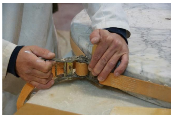
Figura 45: aperto dos fragmentos após aplicação da resina através de correia com roquete.
