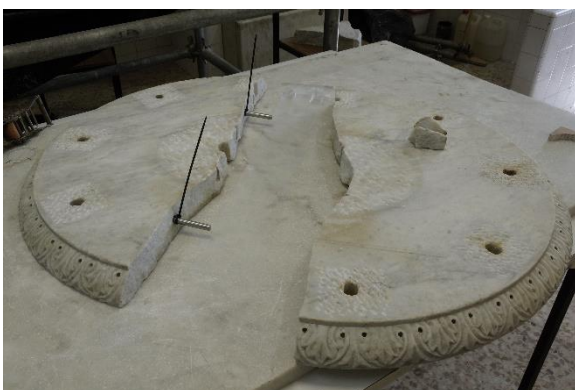
Figura 40: posicionamento dos espigões na base das colunas da fonte decorativa.
