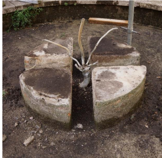
Figura 26: ramificação da tubagem do sistema hidráulico.
