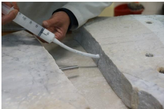
Figura 42: injeção de resina epóxida nas perfurações efetuadas.
