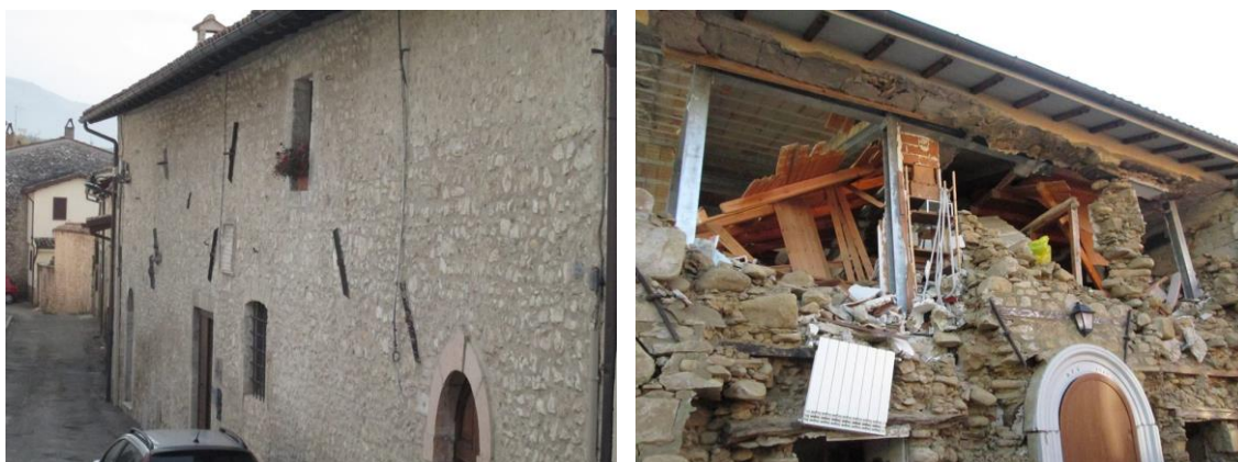
Fig. 10 – Aplicação de tirantes na contenção de fachadas após o sismo de Amatrice em Agosto de 2016 (imagens de Cristina Oliveira)
