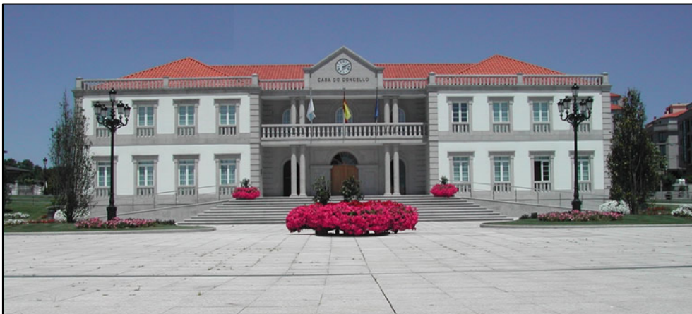
Fig 68. Imagen de la nueva Casa Consistorial.
