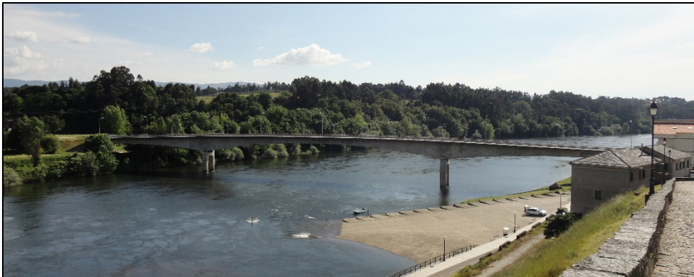
Fig 70. Imagen actual del Puente Internacional Salvaterra-Monção.
