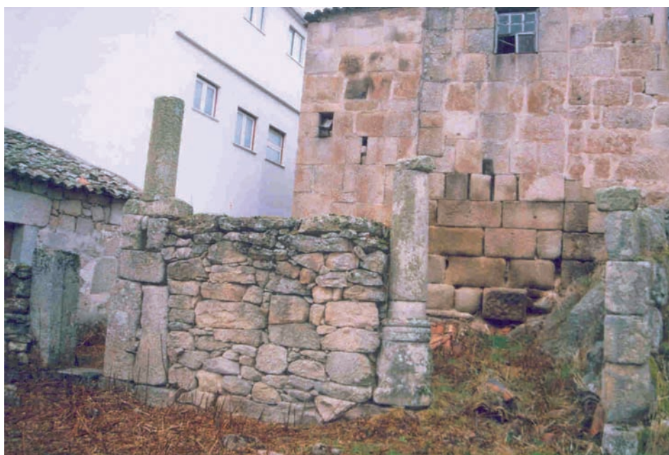
fig. 35 Edifício e logradouro em Marialva (lugar da Devesa) onde poderá estar implantado um provável templo romano dedicado a Júpiter.
