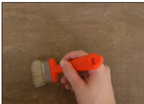
Fig. 98. Remoção de sujidade desagregada. A.P.
