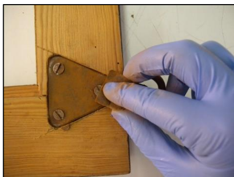
Fig. 124. Remoção da oxidação. A.P.
