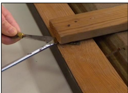
Fig. 96. Remoção de pregos na tábuas de reforço. A.P.
