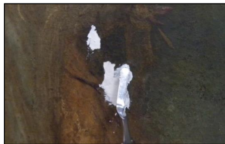
Fig. 115. Preenchimento com modostuc©. A.P.
