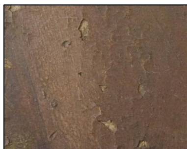
Fig. 95. Após a fixação. A.P.
