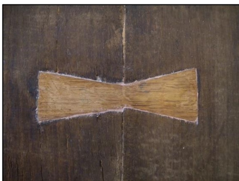
Fig. 106. Aspecto do reforço e da pasta de preenchimento antes da secagem. A.P.
