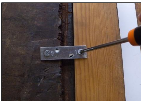
Fig. 130. Colocação das chapas. A.P.
