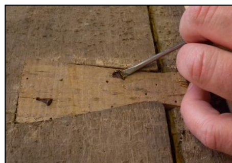
Fig. 97. Levantamento de um prego na dupla cauda de andorinha. A.P.
