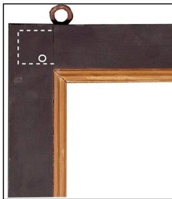
Fig. 42. Liga  o caixa e espiga com cavilha. A.P.
