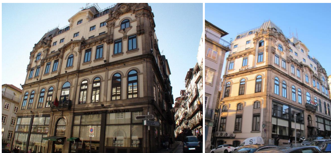
Figura 3 - Fotos da Fachada do Prédio
