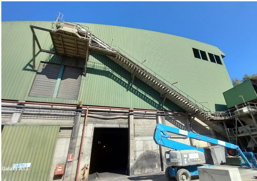
Figura A.1 - Hangar O4 utilizado para armazenar CDRs na Secil e transportador de lâminas de transporte de CDRs ao topo do hangar.
