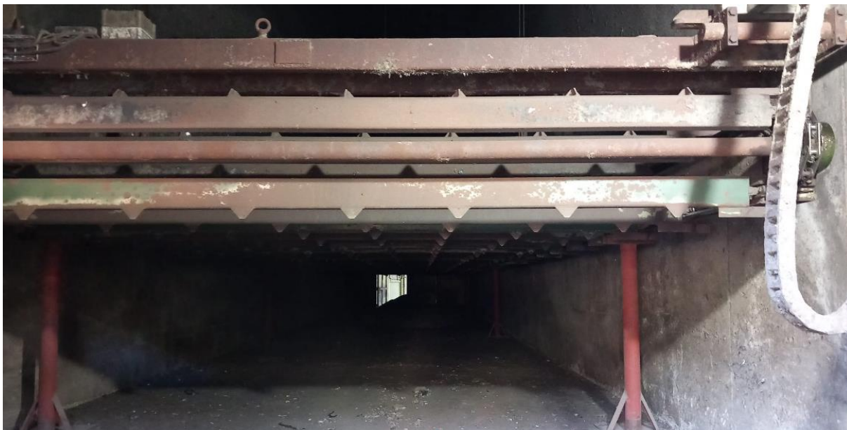
Figura A.3 - Grade no interior da boxe de armazenamento de CDRs do Hangar O4
