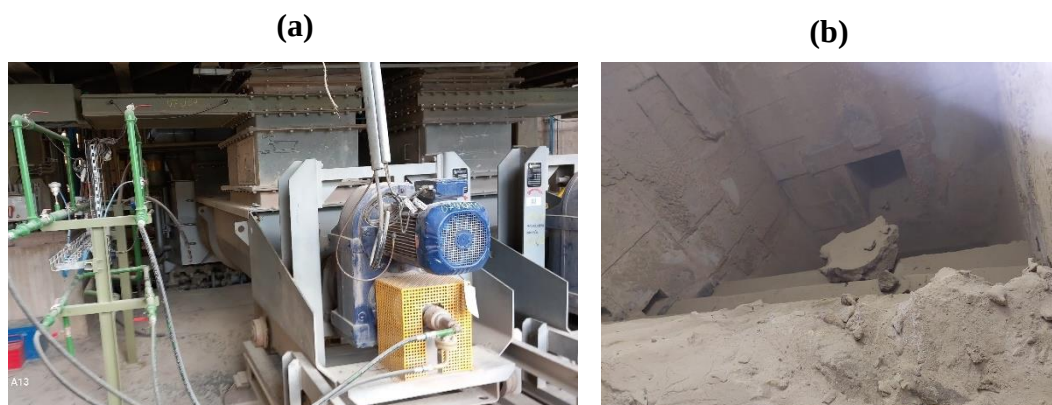
Figura 3.5 - Transportadores de alimentação de CDRs ao Prepol (a) e câmara de combustão do Prepol (b).
