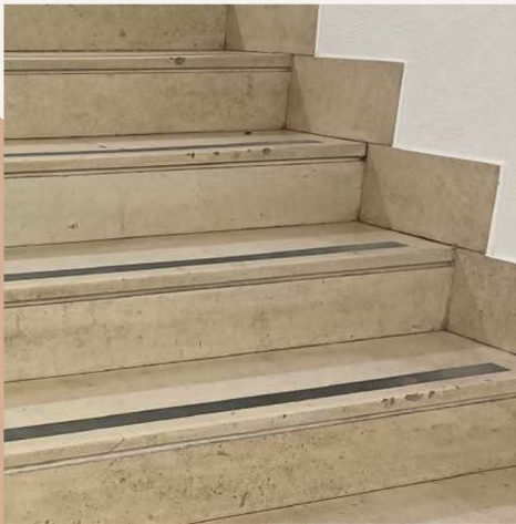
Marcação do limite de escadas
