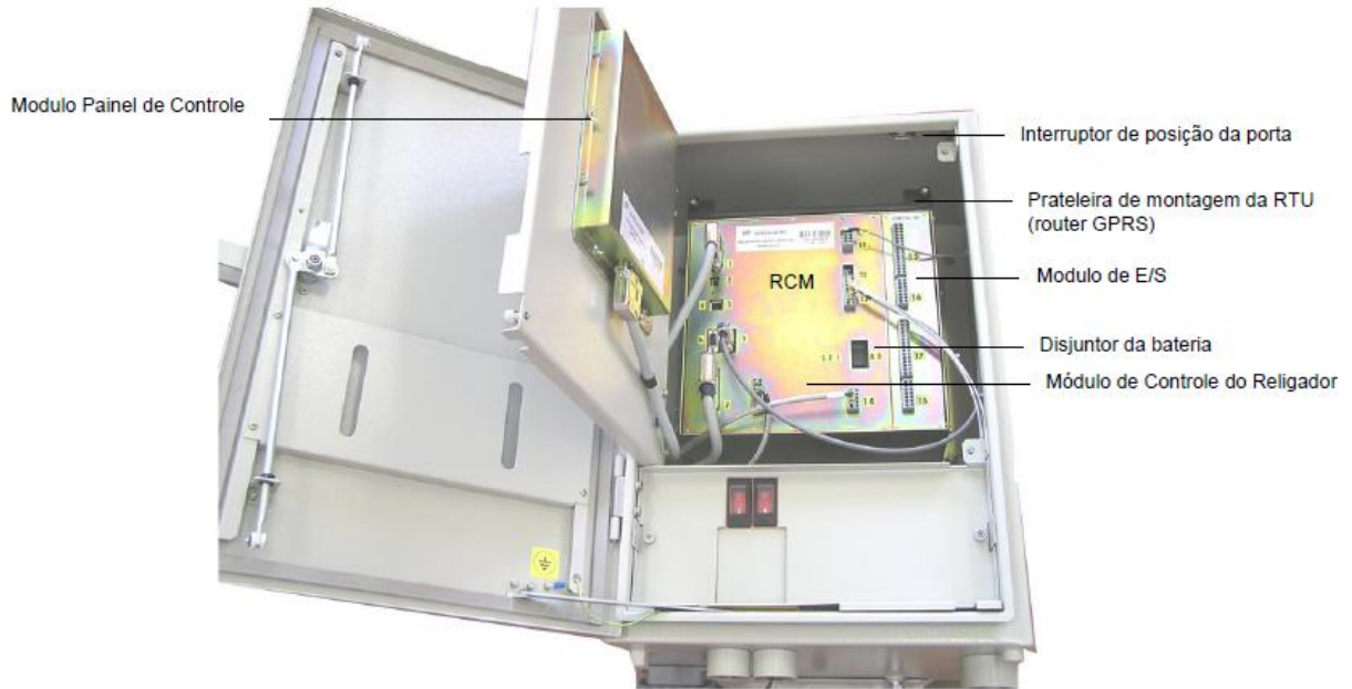
Figura 3.22 – Vista frontal interior.
