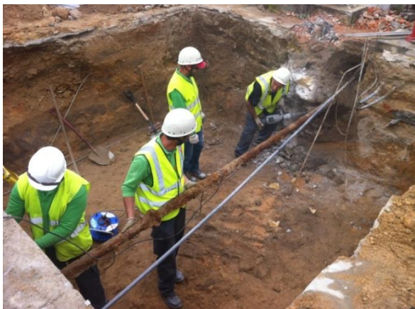
a) Abertura das fundações e instalação dos eletrodos de terra
