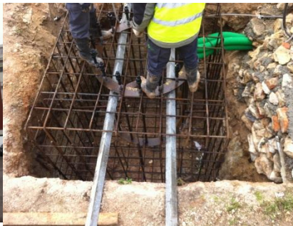
b) Execução fundação
