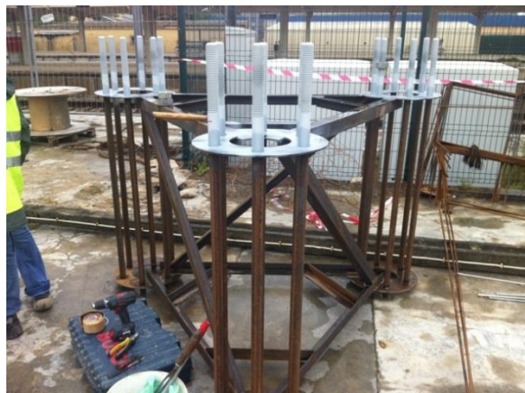
b) Base de fixação da torre
