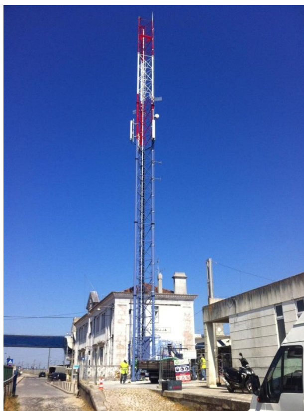
Figura 91. Nova torre instalada
