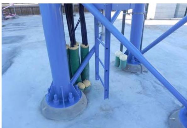
d) Base da torre instalada
