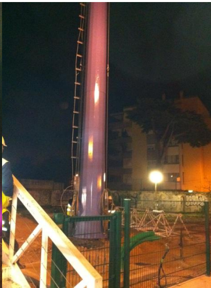
h) Instalação da torre
