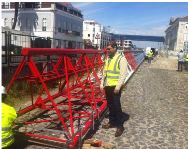
Figura 89. Nova torre de 35m a ser preparada para instalar
