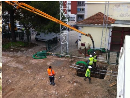
c) Enchimento fundação
