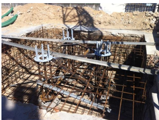
c) Fundações e base de suporte da torre dentro da fundação
