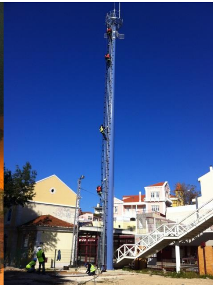
i) Instalação de antenas
