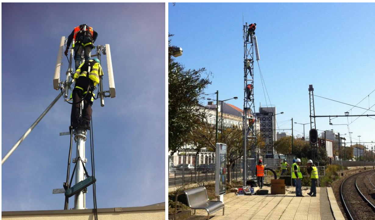
a) Trabalhos de instalação das antenas e cabos GSM-R em S. Apolónia.
