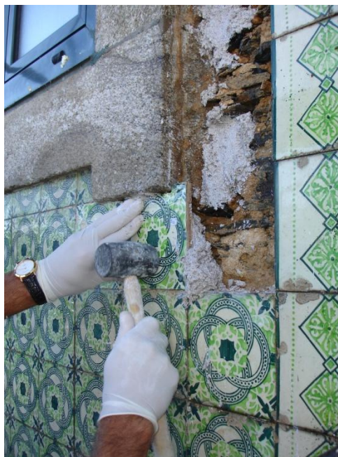
Recolocação de azulejos
