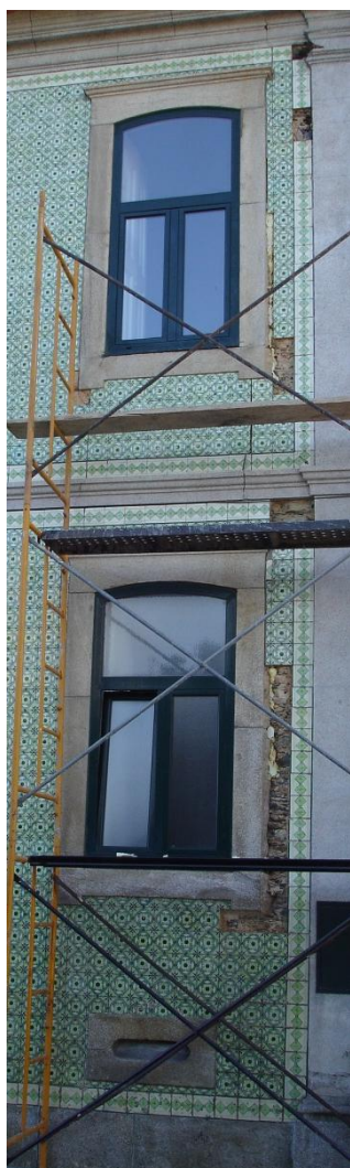
Pormenor da fachada após a remoção de azulejos
