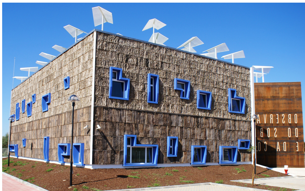
Figura 2 – Aglomerado expandido de cortiça em isolamento térmico pelo exterior.
