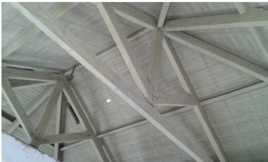
Figura 38. Levantamento fotográfico do sistema de asnas.
