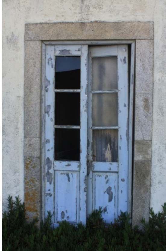
Figura 39. Levantamento fotográfico das portas exteriores.
