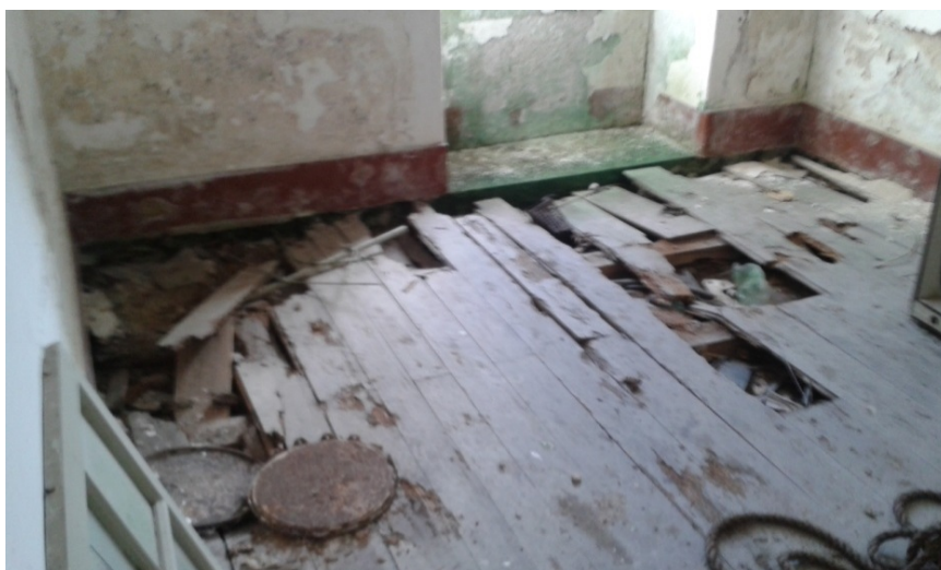
Figura 36. Levantamento fotográfico do piso em soalho.
