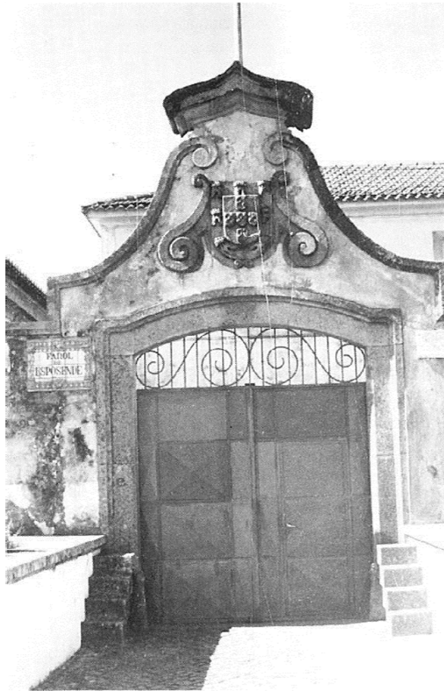
Figura 21 – Portal de acesso ao Forte no seu estado atual.
