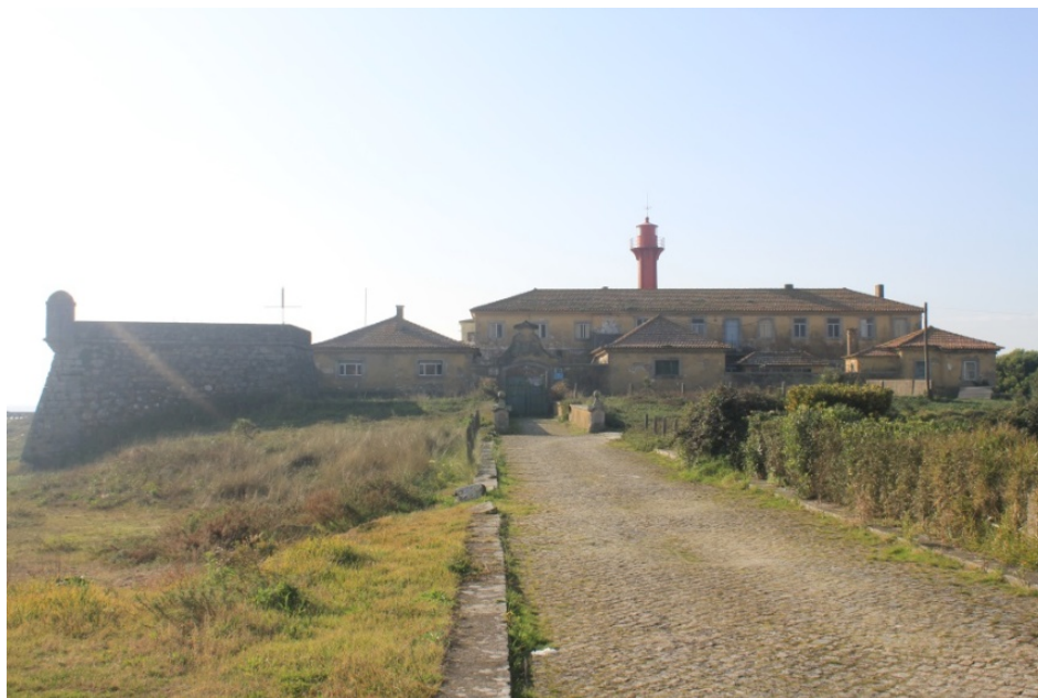
Figura 34. Levantamento fotográfico fachada nascente.
