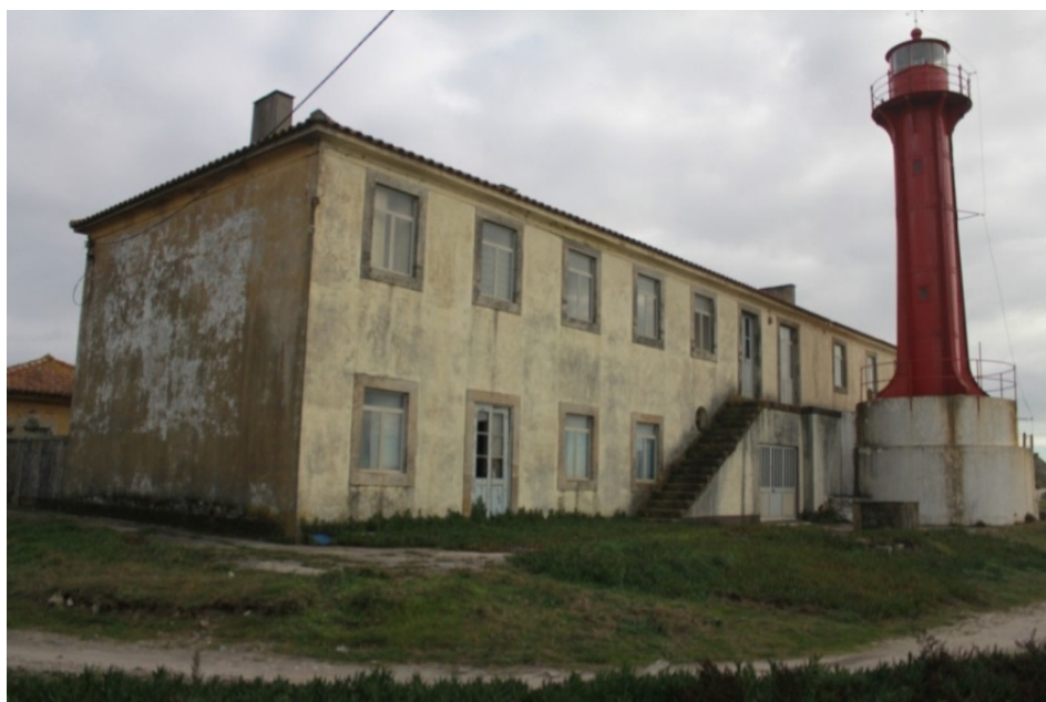
Figura 35. Levantamento fotográfico fachada norte poente.
