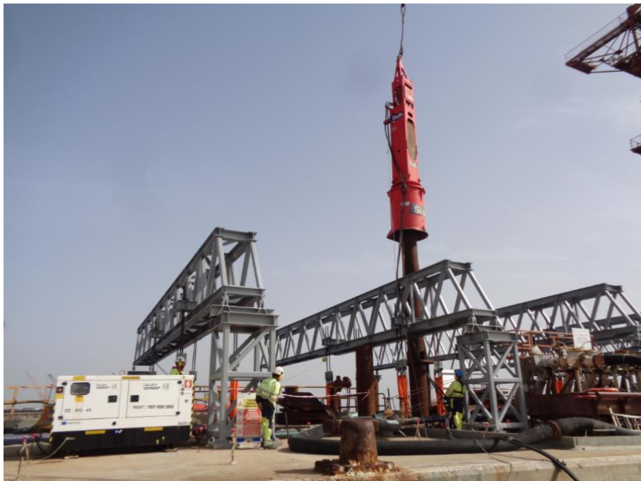
Figura 19 Reabilitação e reforço de uma ponte cais, na Tanquisado (2021 a 2023)
