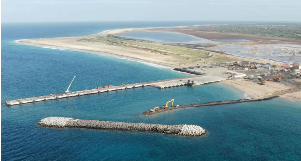
Figura 18 Ampliação e modernização do Porto Inglês, na Ilha do Maio (2019 a 2022)
