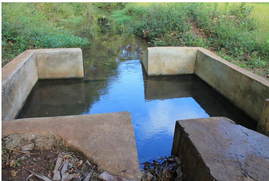
Figura 35 – Nascente do canal de irrigação
