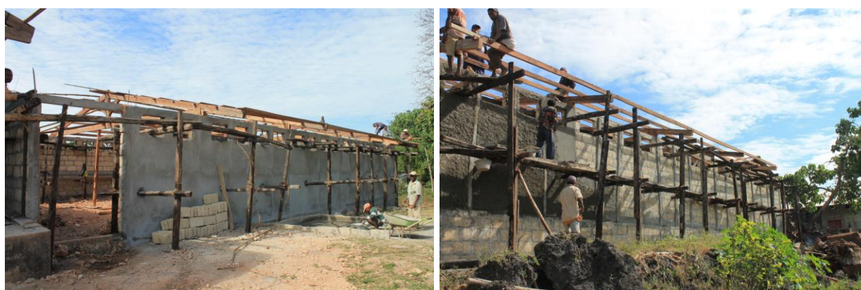
Figura 53 – Construção da coelheira na Escola de Fatumaca
