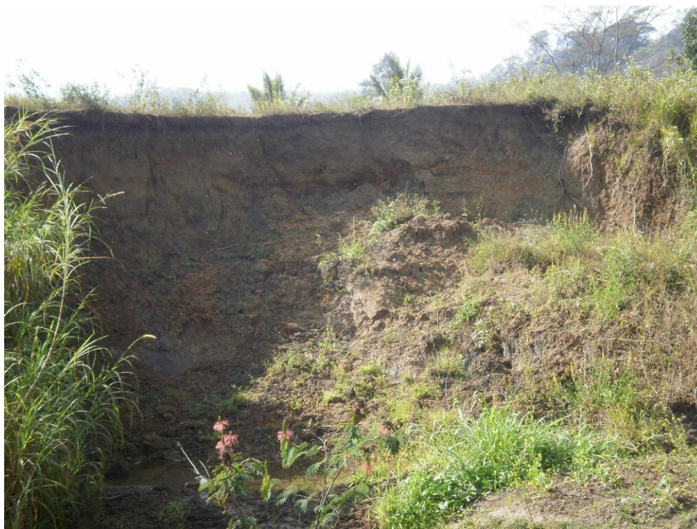
Figura 11 – Exemplo de terreno que sofreu erosão.
