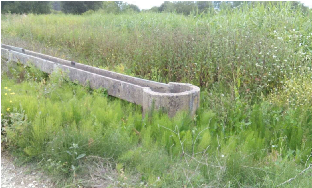
Figura II.6. Pormenor de uma caleira de rega, junho de 2019.
