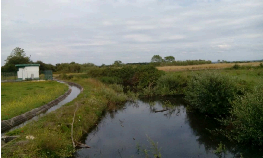
Figura II.7. Vala de drenagem, junho de 2019.
