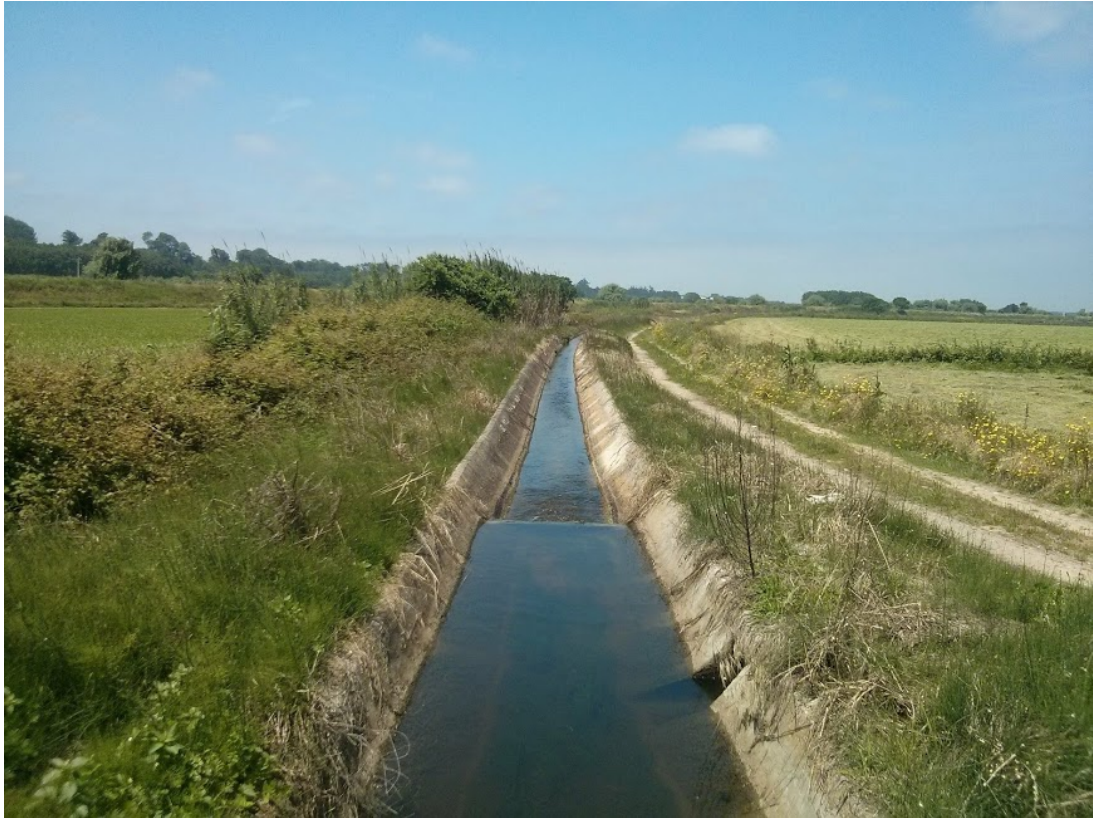
Figura II.5. Canal de rega em betão. Fonte: José Manuel Gonçalves, 2018.
