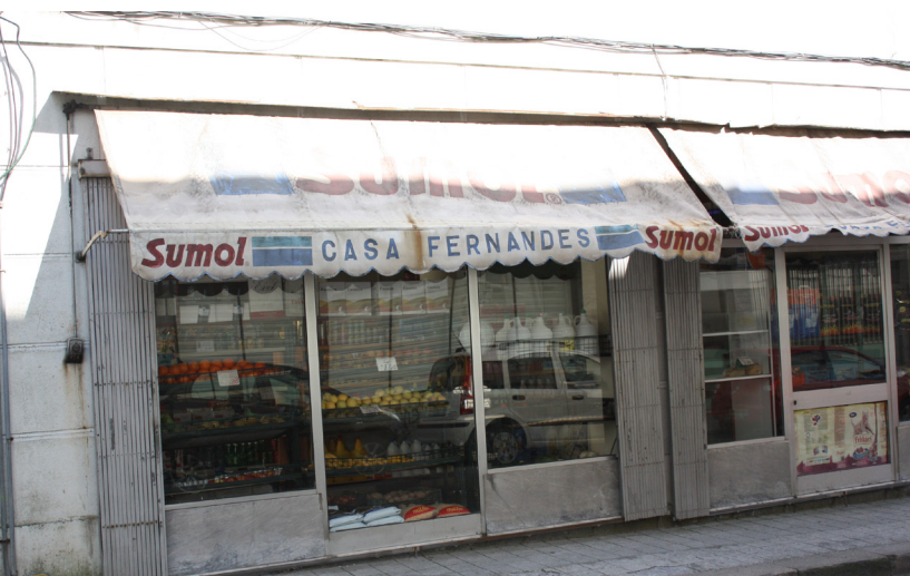
Imagem 109 – Toldo adjacente à montra da Rua de Adolfo Casais Monteiro
