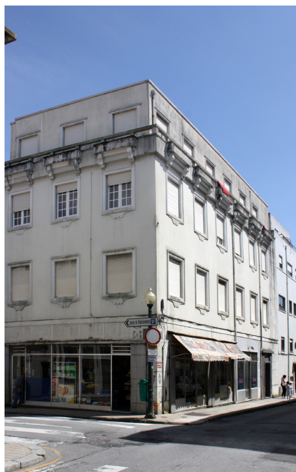
Imagem 113 – Edifício do ponto de venda
