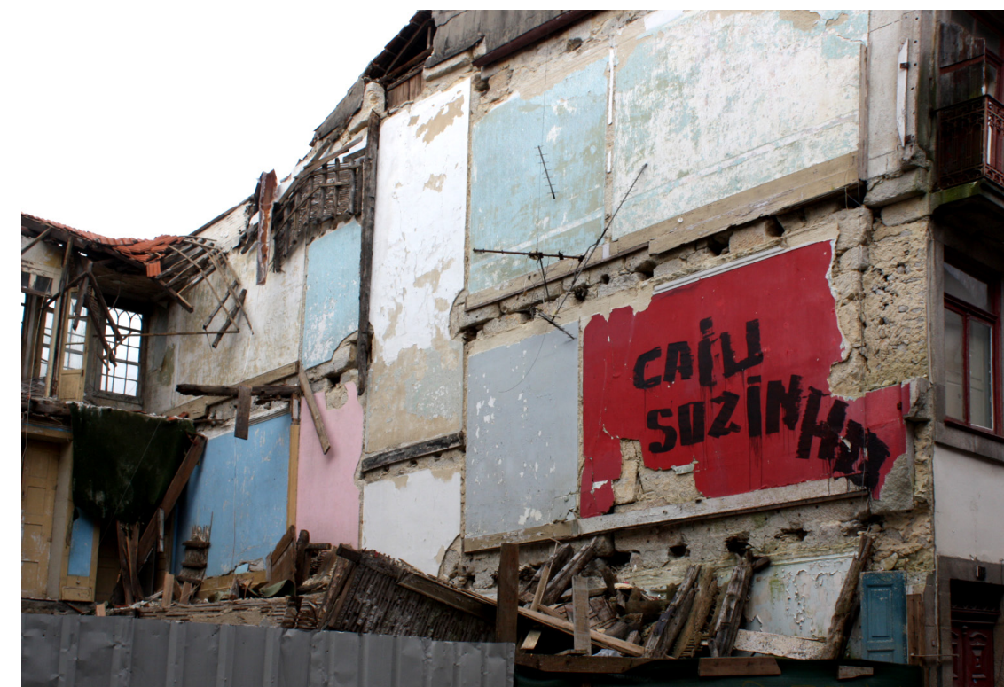
Imagem 82 - Intervenção na casa que derrocou em Agosto de 2010, Rua Miguel Bombarda, Porto
