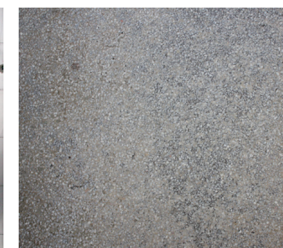
Imagem 123 - Pavimento em marmorite contínua
