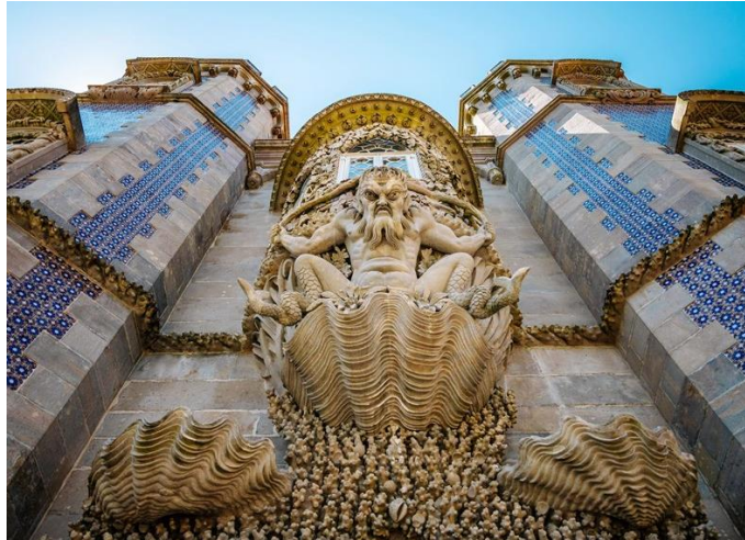
Fig.104. Janela sob o Túnel do Tritão.
