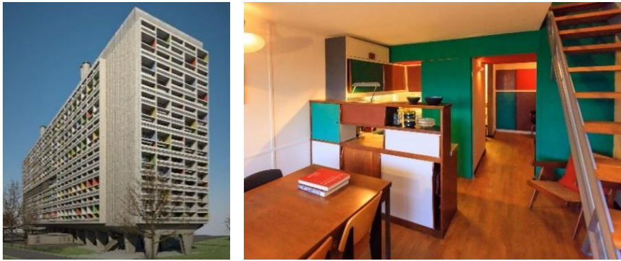
Fig.12. e Fig.13. Unité d'Habitation, Marselha, França – Le Corbusier, 1952.
