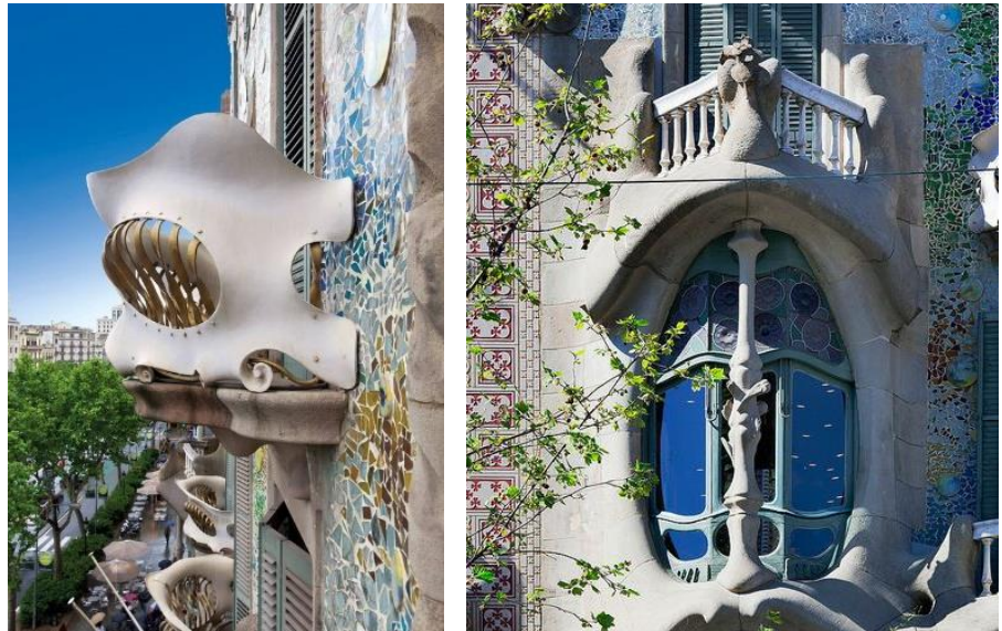
Fig.68. e Fig.69. Pormenores Fachada Principal.
