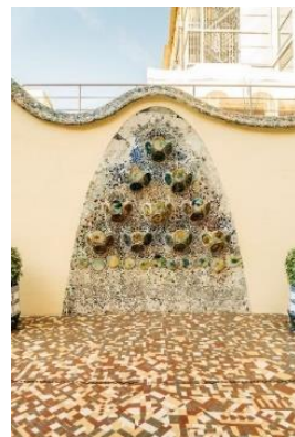
Fig.76. e Fig.77. Pormenores Pátio Exterior.
