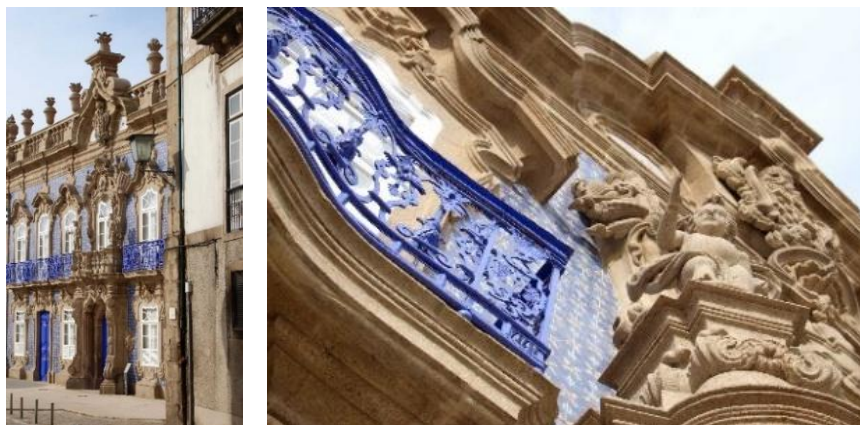
Fig.86. e Fig.87. Pormenores Fachada Principal.
