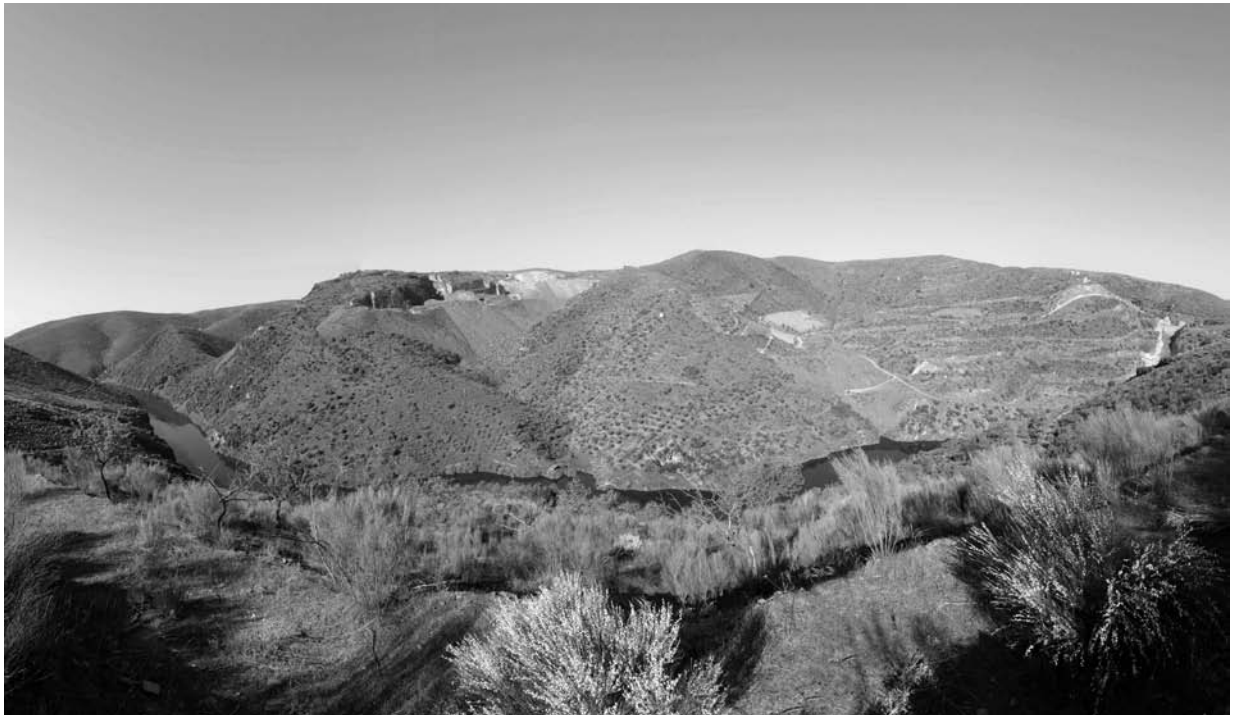
Fig. 13 – Em cima, vê-se a estrada que desce de Vila Nova de Foz Côa para o rio, primeiro ao longo de Vale de Moinhos, continuando depois pela encosta dos Moinhos de Cima, e cortando a foz do Vale do Forno antes de atravessar o rio pela ponte, no início da encosta da Foz do Côa. Na margem oposta aos Moinhos de Cima está a encosta da Broeira. Em baixo, vê-se em frente a Canada do Inferno, por baixo das pedreiras do Poio. Para a direita encontra-se o Rego da Vide, fortemente afectado pelas obras da barragem. Para a esquerda, vê-se o monte cónico do Teixugo, rodeado por Vale de Videiro por um lado e Vale de Figueira por outro, e tendo o Monte Fariseu por detrás.
